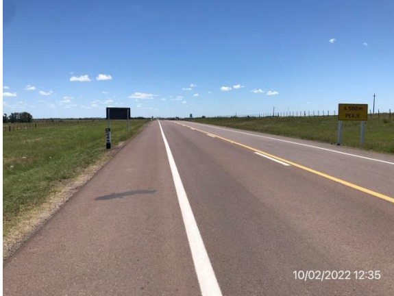
Ilustración 4 – P01, Ruta 5 progresiva 245K000. Inicio de tramo.
