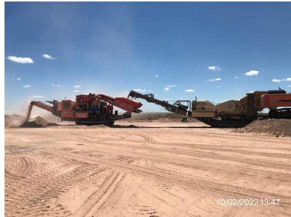
Ilustración 19 – P03. Cantera Sector de trituración primaria.
