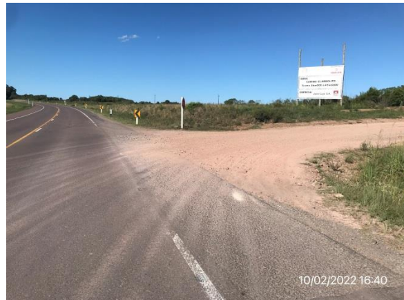
Ilustración 13 – P07, Fin de obra 4, Ruta 5 progresiva 348K000.
