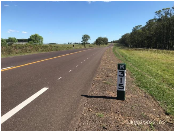
Ilustración 12 – P06, Fin de obra 1, Ruta 5 progresiva 315K000.
