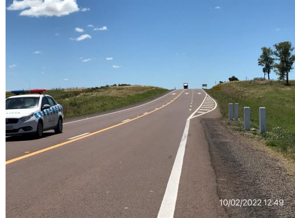
Ilustración 5 – Ruta 5, Inicio de tramo de tercera vía de sobrepaso.
