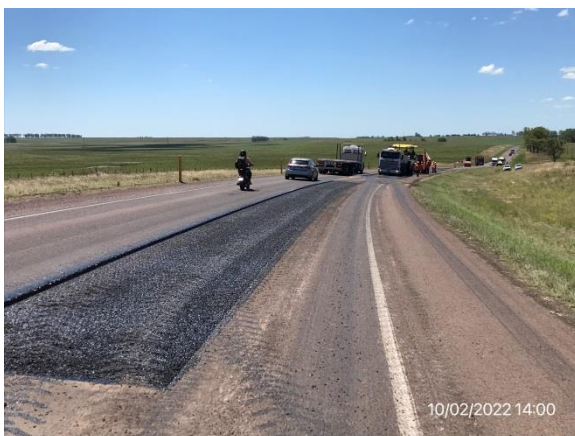
Ilustración 8 – P04, Frente de obra. Ruta 5 progresiva 294K000. Tareas de fresado en ejecución
