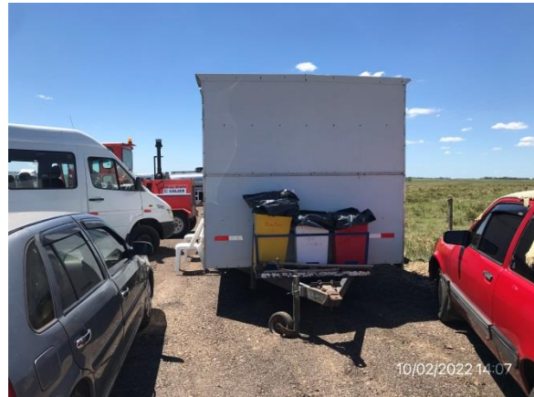
Ilustración 11 – P04, Frente de obra. Ruta 5 progresiva 294K000. Servicios y estación de residuos segregados por origen.
