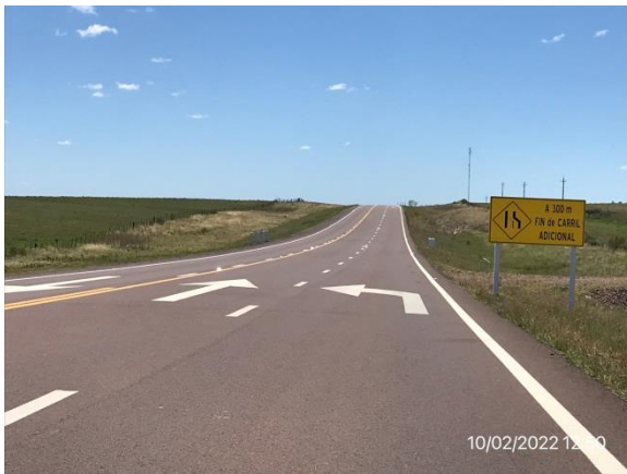
Ilustración 6 – Ruta 5, tramo de tercera vía de sobrepaso terminada
