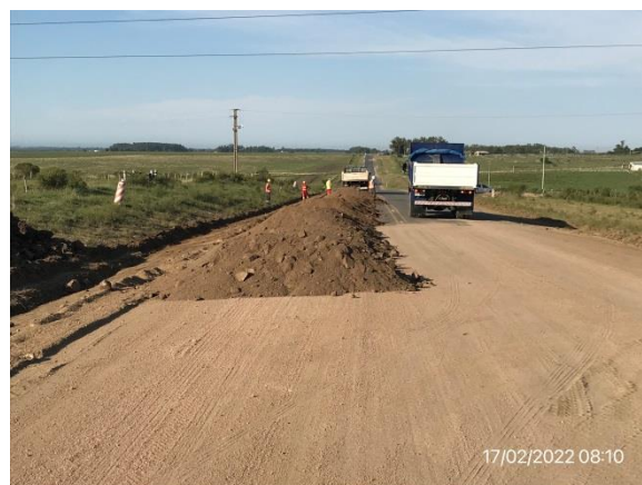
Ilustración 7 – P07, Frente de obra. Ruta 6, progresiva 210K100.
