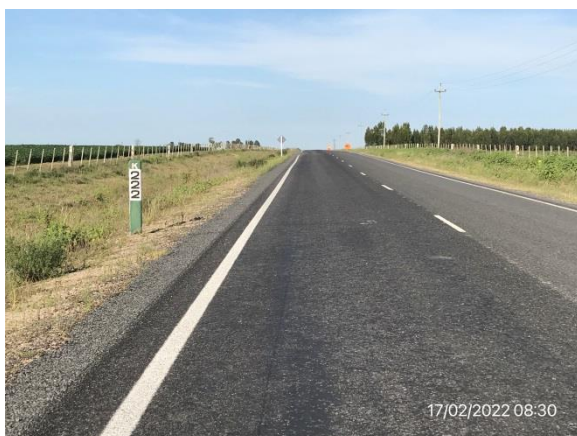
Ilustración 6 – Tramo de Ruta 6 con obras terminadas, señalización horizontal ejecutada.
