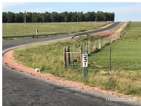
Ilustración 9 – P02, Fin de tramo. Ruta 6, progresiva 231K000.
