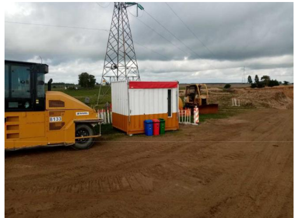
Ilustración 19 – P04, Cantera de tosca. Nueva infraestructura de servicios. Evidencia proporcionada por la empresa el 21/02/2022.
