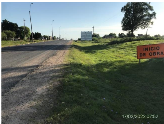
Ilustración 4 – P01, Inicio de obras. Ruta 6, progresiva 206K000. Ingreso a localidad de Sarandí del Yí.
