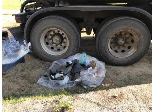
Ilustración 17 – P05, Cantera y campamento provisorio. Ruta 6 progresiva 222K800 a (-). El depósito de residuos no cumple con requerimientos.
