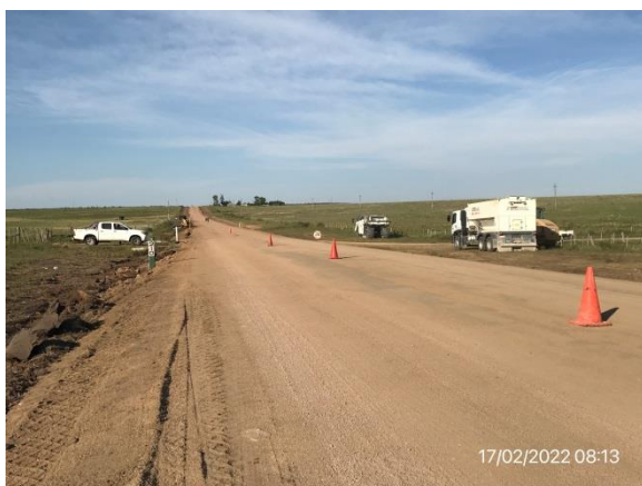
Ilustración 8 – P07, Frente de obra. Ruta 6, progresiva 210K100.
