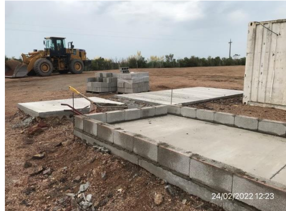
Ilustración 5 – P03, Obrador. Infraestructura en construcción para decantación de efluentes.
