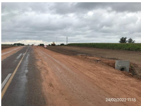
Ilustración 14 – Tramo en obra, Ruta 81. Tareas de recargo y ensanche de plataforma culminadas, nuevas alcantarillas para entradas particulares construidas.
