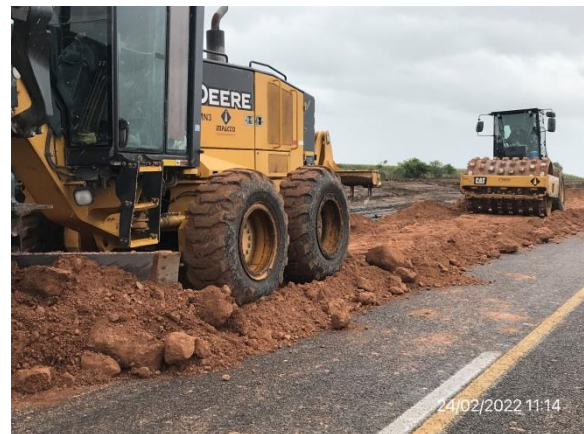
Ilustración 13 – P04, frente de obras, Ruta 81, progresiva 53K900. Tareas de recargo granular en curso.
