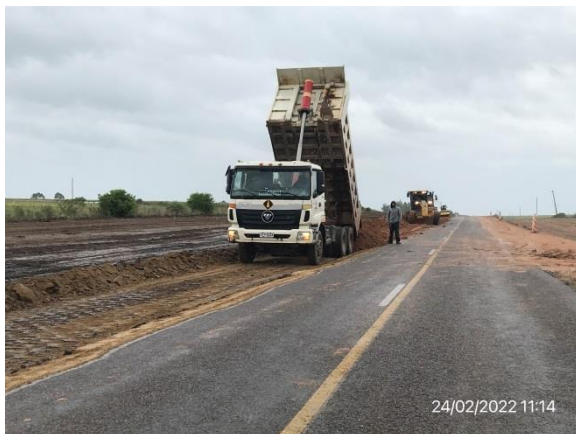
Ilustración 12 – P04, frente de obras, Ruta 81, progresiva 53K900. Tareas de ensanche de plataforma, en curso.
