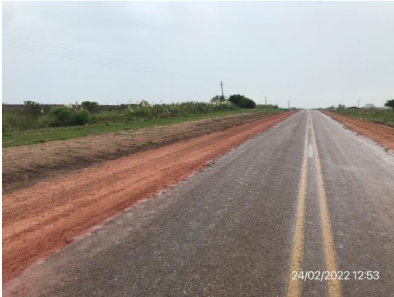
Ilustración 16 – P02, Fin de tramo. Ruta 81, progresiva 48K500. Interfase entre contratos C/72 ampliación y C/76 ampliación.
