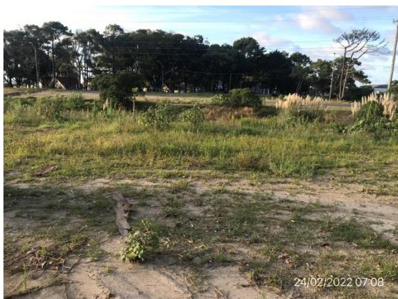
Ilustración 6 – P01, Campamento provisorio lindero a nueva rotonda. Explanada recuperada.
