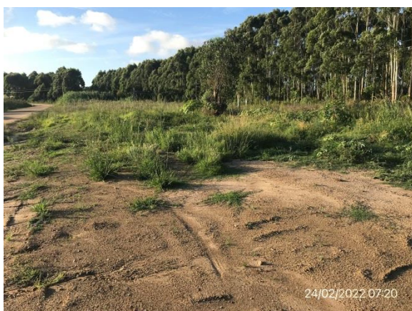
Ilustración 8 – P02, Campamento provisorio desmontado en faja pública de Ruta 10. Empastado en proceso.
