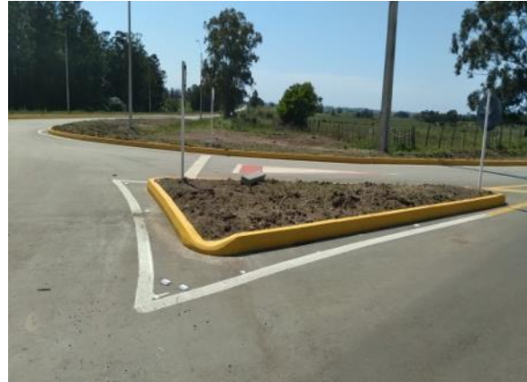
Ilustración 11 – Islas de acceso al empalme con acceso a relleno sanitario Intendencia de Rocha, empastado incipiente. Fotografía proporcionada por la empresa el 22/10/2021.
