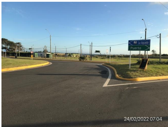
Ilustración 4 – P01, Nueva rotonda de desvío del tránsito pesado al puerto de La Paloma. Obras terminadas.
