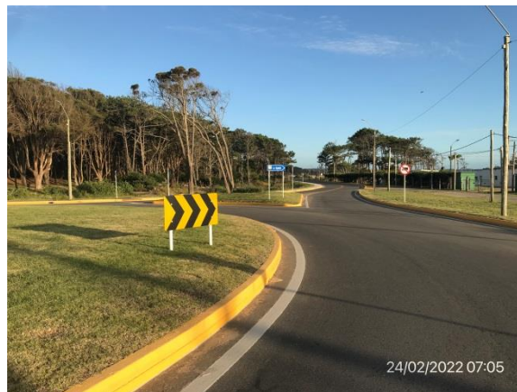
Ilustración 5 – P01, Nueva rotonda de desvío del tránsito pesado al puerto de La Paloma. Señalización culminada.
