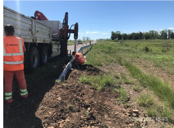
Ilustración 11 – P05, Frente de obra subcontratista Serviam SA. Instalación de señalización vertical y defensas metálicas.
