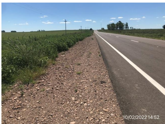
Ilustración 6 – Ruta 43. Banquinas ejecutadas y faja pública limpia.
