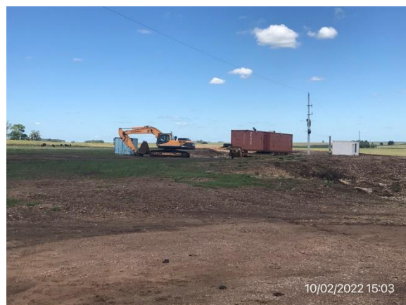
Ilustración 7 – P03, Obrador parcialmente desmontado, Ruta 43 progresiva 35K000. Tiene plazo hasta el 10/04/2022 para desmonte total.
