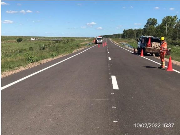
Ilustración 10 – P05, Frente de obra subcontratista Serviam SA. Instalación de señalización vertical y defensas metálicas.
