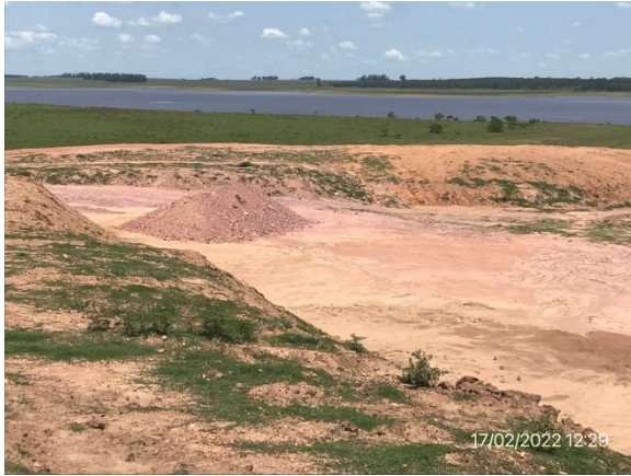
Ilustración 16 – P08, Cantera de tosca y piedra partida. Cno. a la Balsa 8K300 a (+). Taludes suavizados y acopios remanentes a beneficio del propietario.
