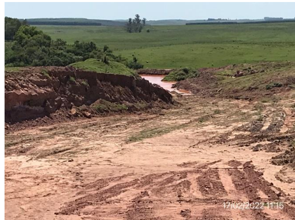
Ilustración 19 – P09, Cantera de tosca y piedra, Cno. a la Balsa 36K800 a (+). Taludes suavizados y laguna de decantación operativa.
