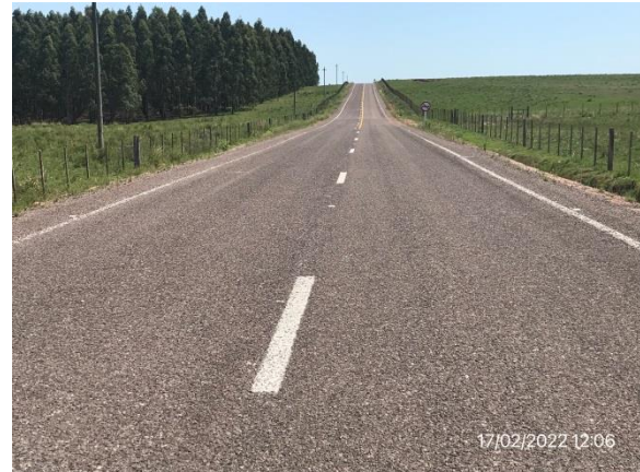
Ilustración 5 – Camino a la Balsa, obras terminadas. Faja pública recuperada.
