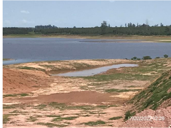
Ilustración 17 – P08, Cantera de tosca y piedra partida. Cno. a la Balsa 8K300 a (+). Laguna de decantación operativa.
