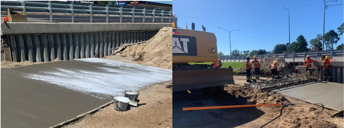
Los muros en el interior del túnel se hicieron usando las tablestacas de encofrado perdido, revistiéndolas con la armadura necesaria, y proyectando el hormigón. En la parte inferior de los hierros se dejaron esperas para la posterior ejecución del pavimento.
