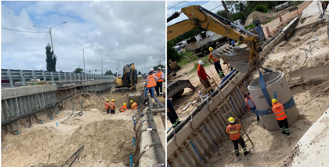
Por otro lado, la excavación del túnel Oeste no requirió bombeo de la napa por tratarse de suelo arcilloso.
