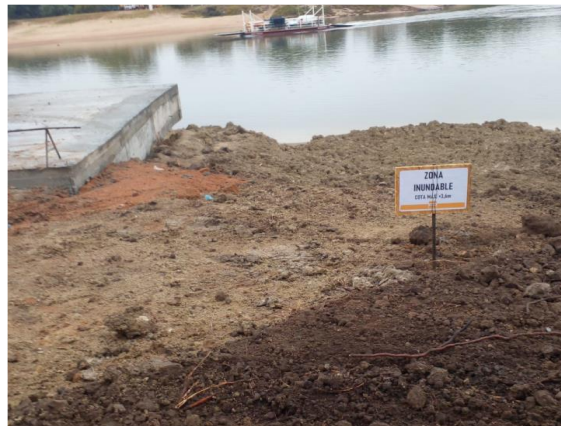
Ilustración 18 – P01, Cabecera Oeste del nuevo puente. Cartelería indicativa de la cota de máxima creciente colocada con posterioridad a la auditoría. Fotografía suministrada por la empresa el 26/04/2022.
