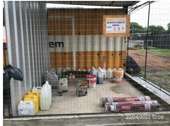
Ilustración 11 – P03, Obrador de SACEEM. Depósito de productos químicos techado con pavimento y envallado impermeables.
