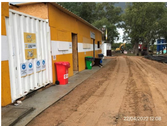
Ilustración 8 – P03, Obrador de SACEEM. Estación de acopio de residuos segregados por corriente de generación.
