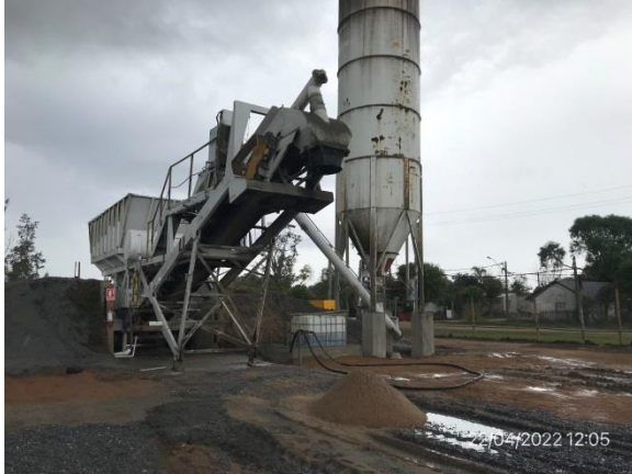
Ilustración 4 – P03, Planta de hormigón de Molinsur SA.
