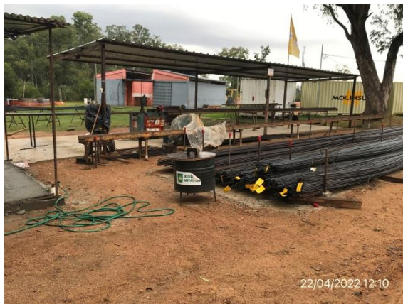
Ilustración 12 – P03, Obrador de SACEEM. Sector de herrería con sector para acopio de residuos.
