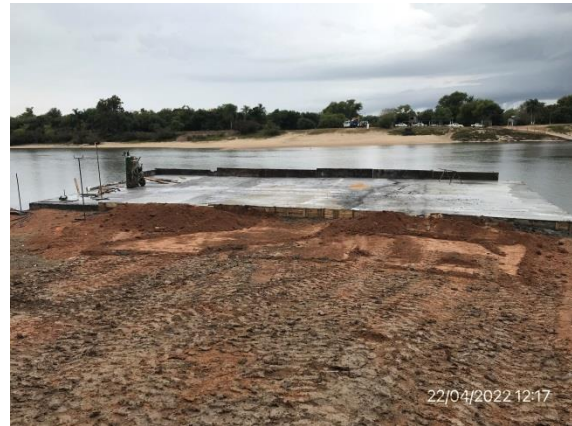
Ilustración 17 – P01, Cabecera Oeste del nuevo puente. No está indicada la cota de máxima creciente.
