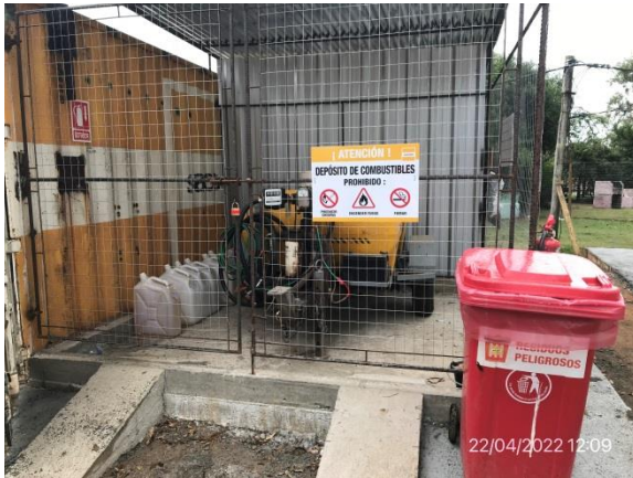
Ilustración 10 – P03, Obrador de SACEEM. Depósito de combustibles techado con pavimento y envallado impermeables.
