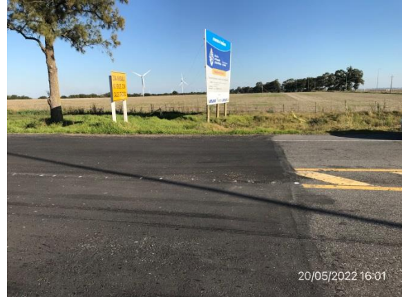
Ilustración 5 – P01, Inicio de tramo. Refuerzo de paquete estructural y nueva carpeta asfáltica de rodadura.
