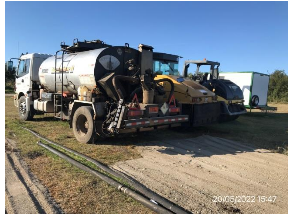
Ilustración 17 – P03, Obrador con actividad mínima. Estacionamiento de maquinaria.
