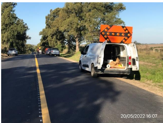
Ilustración 8 – P04, Frente de obras en Ruta 6. Tareas de señalización en ejecución, subcontrato Tecnobalizas SRL.
