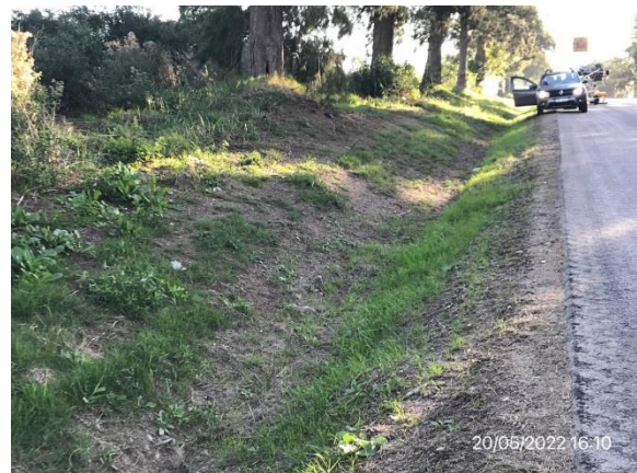
Ilustración 7 – Obras terminadas en Ruta 61. Cunetas conformadas con recuperación ambiental ejecutada y empastado en crecimiento.
