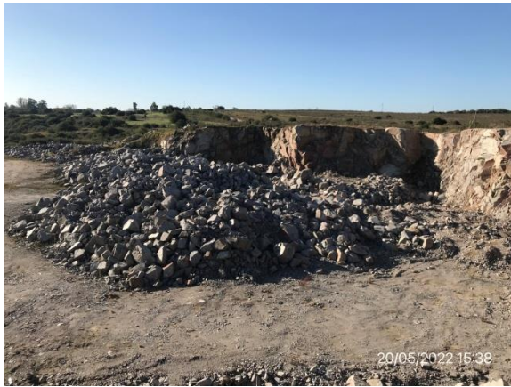
Ilustración 10 – P03, Cantera de piedra sin actividad, Padrón 2.626 de Colonia. Material de voladura sin triturar.
