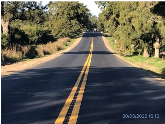
Ilustración 6 – Obras terminadas en Ruta 61. Tramo con tareas de señalización terminadas
