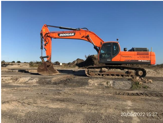
Ilustración 16 – P03, Obrador con actividad mínima. Estacionamiento de maquinaria.
