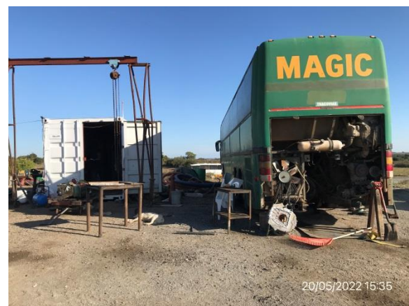
Ilustración 15 – P03, Obrador con actividad mínima. Tareas de mantenimiento mecánico en zona de taller improvisada.
