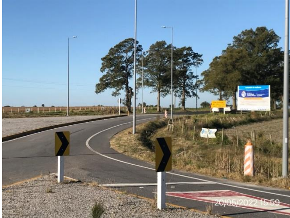
Ilustración 4 – P01, Inicio de tramo. Empalme de Ruta 61 con Ruta 2.
