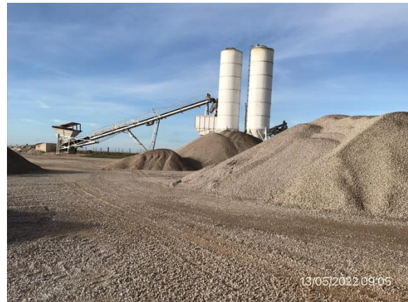
Ilustración 19 – P04, Obrador principal. Planta de hormigón y acopio de áridos
