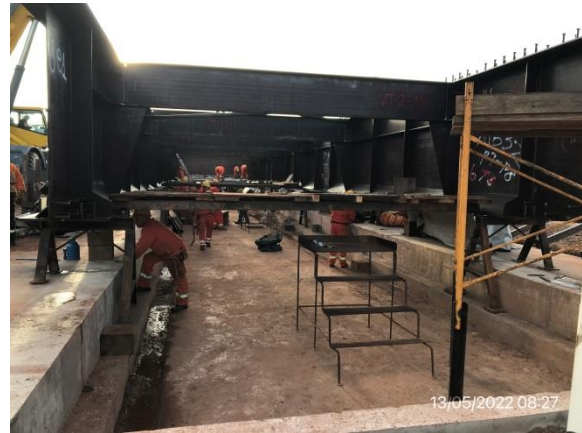
Ilustración 11 – P05, Obrador secundario. Trabajos de posicionado de viga de lanzamiento.
