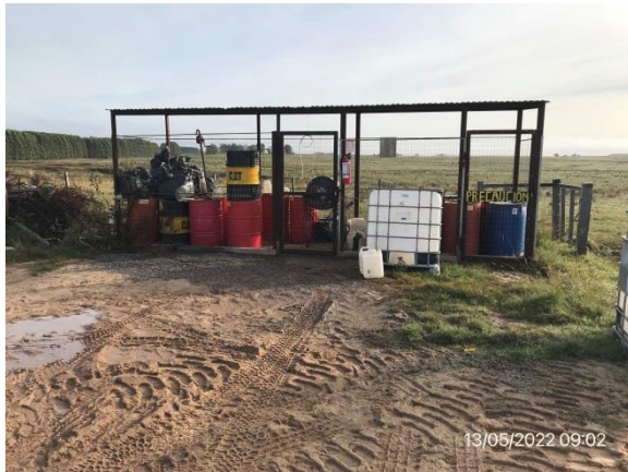
Ilustración 22 – P04, Obrador principal. Depósito techado y con envallado perimetral para hidrocarburos.
