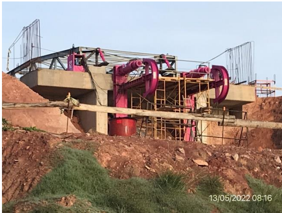
Ilustración 10 – P03, puente en obra. Viga y equipamiento hidráulico de lanzamiento posicionados.
