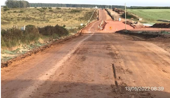
Ilustración 16 – Camino a la Balsa – Paso Oribe. Tareas de recargo granular para perfilado altimétrico y planimétrico en ejecución.
