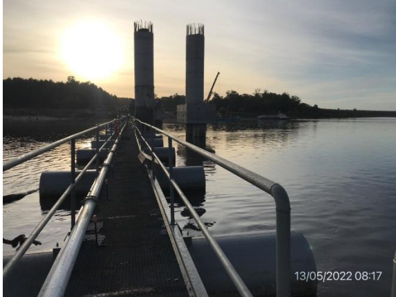
Ilustración 4 – P03, puente en obra. Plataforma flotante de acceso.
