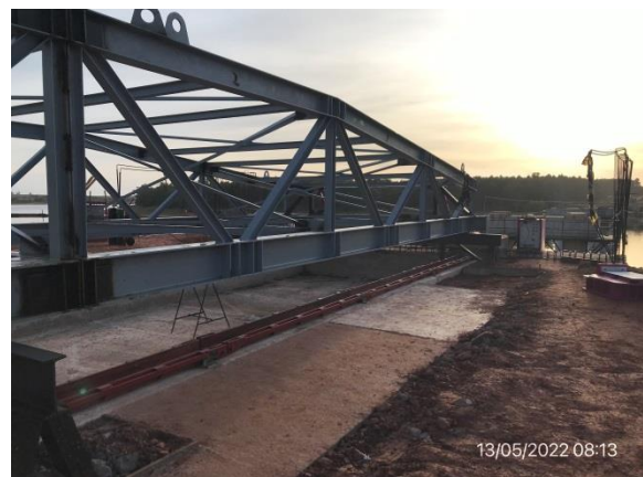
Ilustración 9 – P03, puente en obra. Viga de lanzamiento posicionada.
