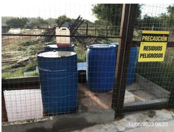
Ilustración 14 – P05, Obrador secundario. Recinto techado, con pavimento impermeable y envallado perimetral para acopio de productos químicos.
