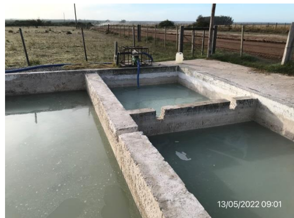
Ilustración 21 – P04, Obrador principal. Pileta de decantación para aguas de lavado de camiones mixer de hormigón.
