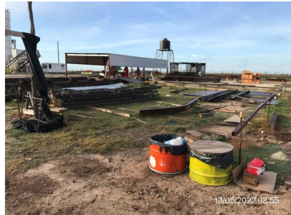
Ilustración 23 – P04, Obrador principal. Estación de acopio de residuos segregados por corriente de generación.
