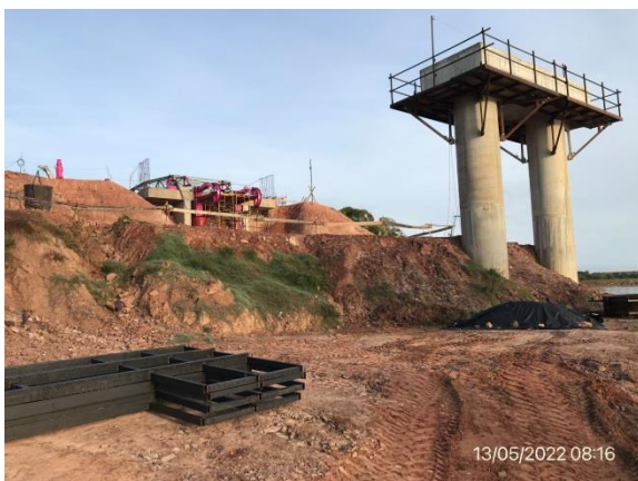
Ilustración 8 – P03, puente en obra. Pórtico en tierra y estribo Oeste ejecutados.
