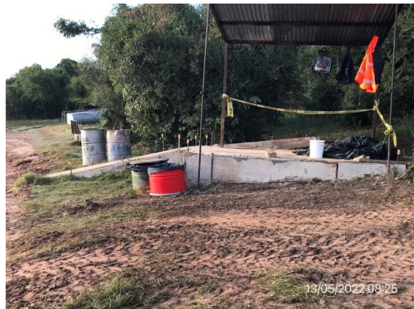
Ilustración 13 – P05, Obrador secundario. depósitos para residuos segregados por corriente de generación
