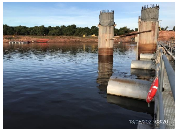
Ilustración 7 – P03, puente en obra. Pilotaje en agua terminado.
