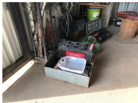
Ilustración 27 – P04, Obrador principal – Pañol. Acopio de baterías en bandeja impermeable.
