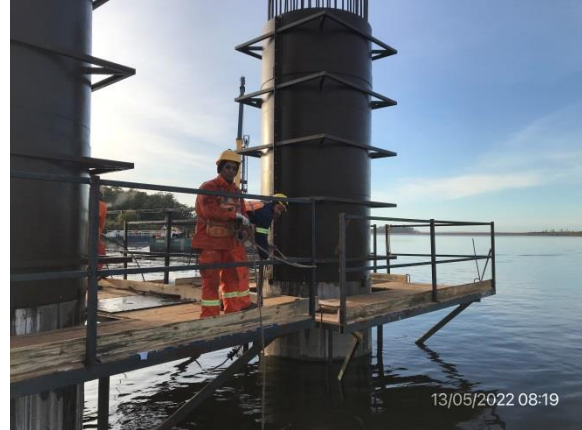
Ilustración 5 – P03, puente en obra. Tareas de ejecución de encofrados metálicos en tramos offshore.
