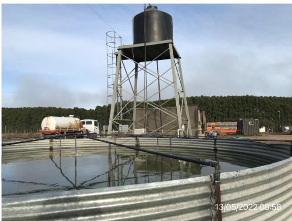
Ilustración 20 – P04, Obrador principal. Depósito de agua extraída de perforación existente.
