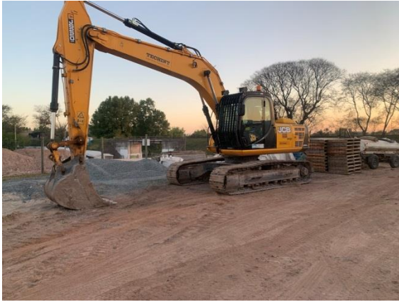
Ilustración 22 – P09, obrador principal. Explanada de maniobras de maquinaria.
