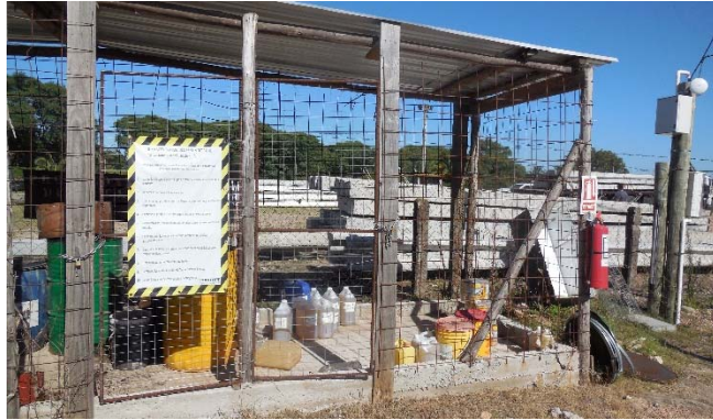
Figura 4-1 Recinto de sustancias peligrosas en obrador principal
