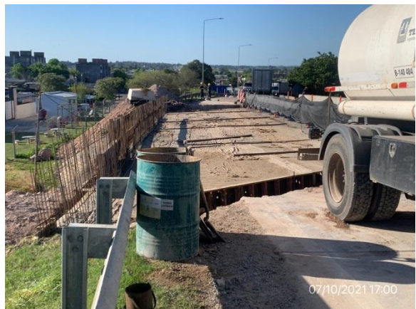
Ilustración 9 – P04, Pasaje superior sobre vía férrea. Terraplenes de ensanche de puente construidos
