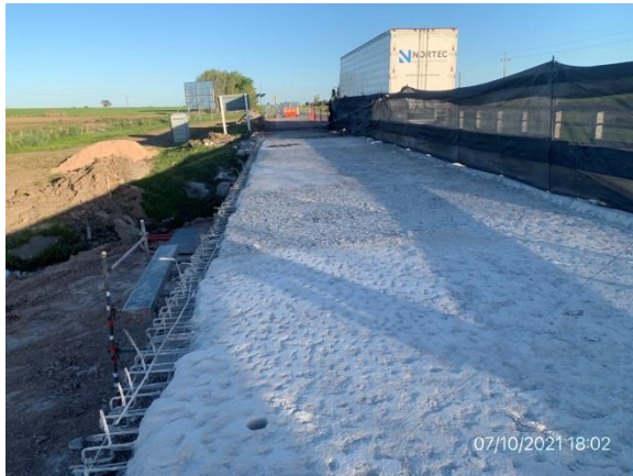
Ilustración 16 – P01, Puente sobre A° La Lancha. Obras de demolición de tablero en proceso
