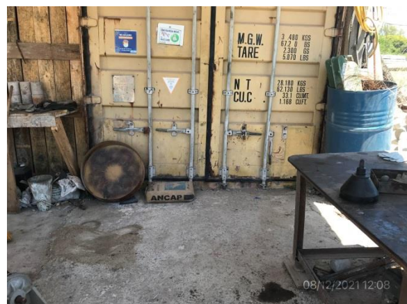
Ilustración 15 – P03, obrador principal. Taller mecánico en contenedores cerrados con techo y pavimento impermeable.
