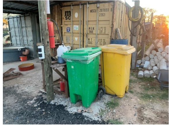
Ilustración 23 – P09, obrador principal. Residuos segregados por origen de generación.
