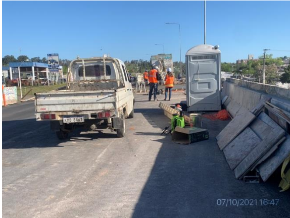
Ilustración 4 – P05, Pasaje superior sobre calle. Ruta 2 progresiva 278K850. Obras en ejecución.
