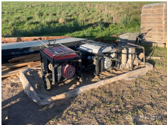
Ilustración 18 – P01, Puente sobre A° La Lancha. Equipos portátiles con bandejas impermeables de contención anti derrames.
