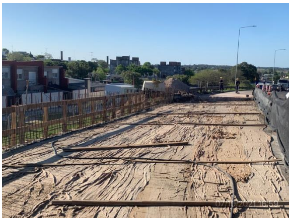
Ilustración 8 – P04, Pasaje superior sobre vía férrea. Ruta 2 progresiva 277K580. Tablero con hormigonado terminado
