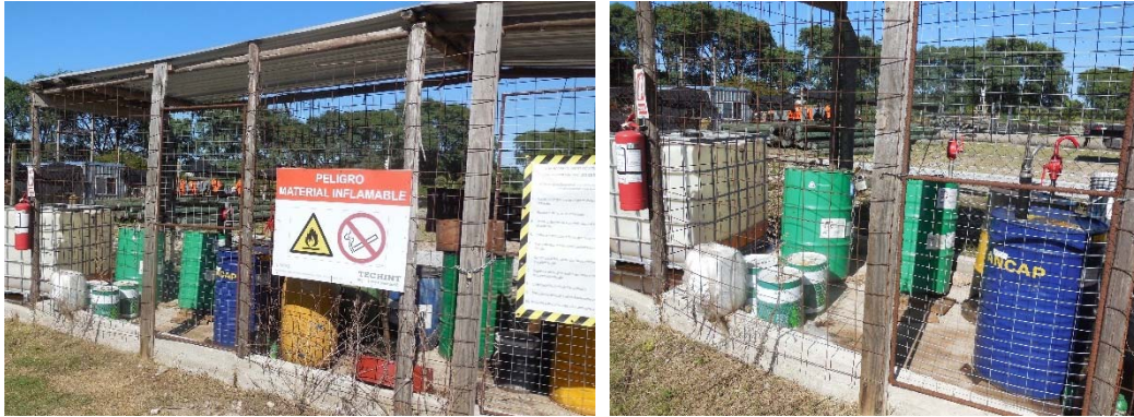
Figura 3-4 Recinto de almacenamiento de combustible en obrador principal
