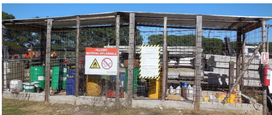
Figura 6-3 Recinto de Acopios de residuos peligrosos.
