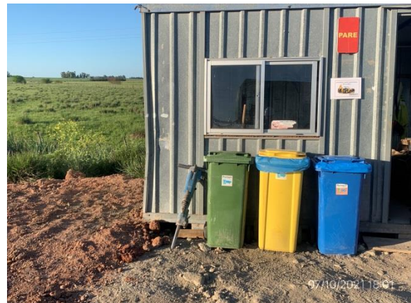
Ilustración 19 – P01, Puente sobre A° La Lancha. Residuos segregados según corriente de generación.
