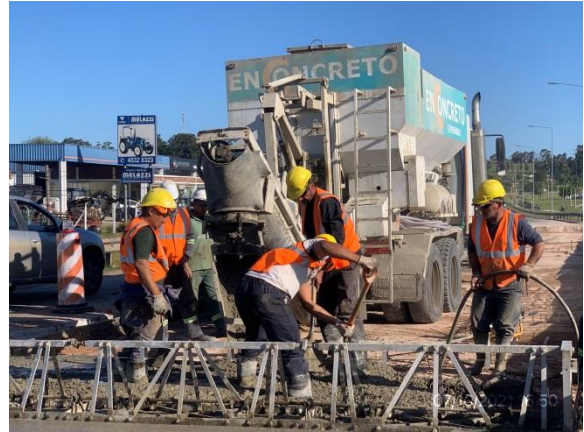
Ilustración 5 – P05, Pasaje superior sobre calle. Llenado de tablero en ejecución.
