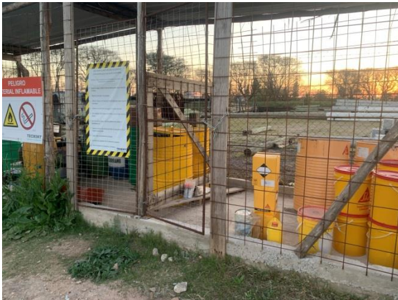
Ilustración 24 – P09, obrador principal. Sector envallado y techado para acopio y trasiego de lubricantes y productos químicos.
