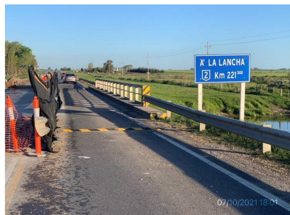
Ilustración 15 – P01, Puente sobre A° La Lancha en ejecución. Ruta 2 progresiva 221K500.
