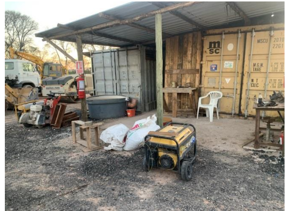
Ilustración 25 – P09, obrador principal. Taller mecánico en contenedores cerrados con techo y pavimento impermeable
