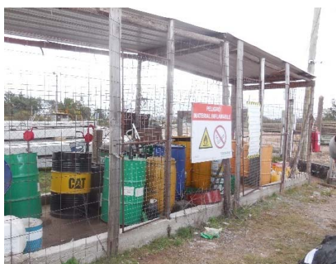
Figura 6-3 Recinto de Acopios de residuos peligrosos.
