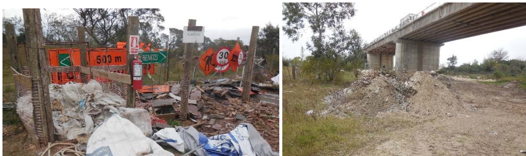
Figura 6-2 Corralitos para ROCs en obrador principal y acopio parcial en frente de obra.
