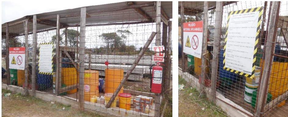
Figura 3-4 Recinto de almacenamiento de combustible en obrador principal
