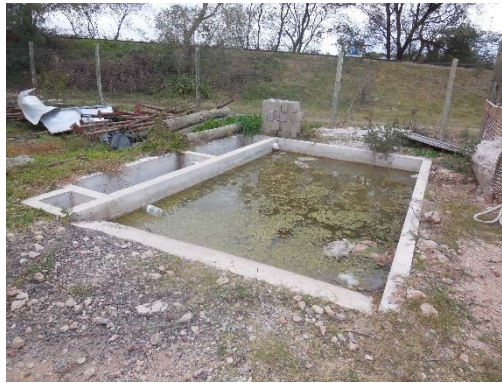
Figura 6-4 Pileta de lavado de mixer.
