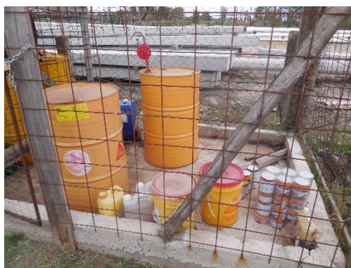
Figura 4-1 Recinto de sustancias peligrosas en obrador principal
