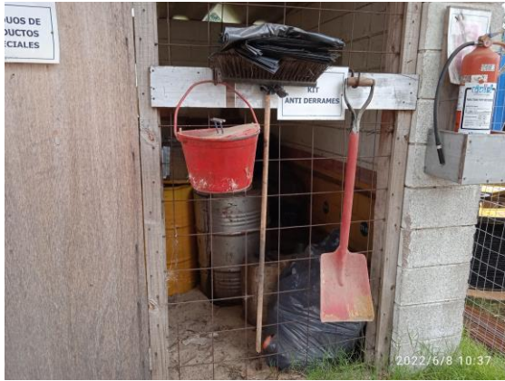
Ilustración 10 – P03, Obrador. Kits antiderrames en depósito de productos químicos y residuos especiales.
