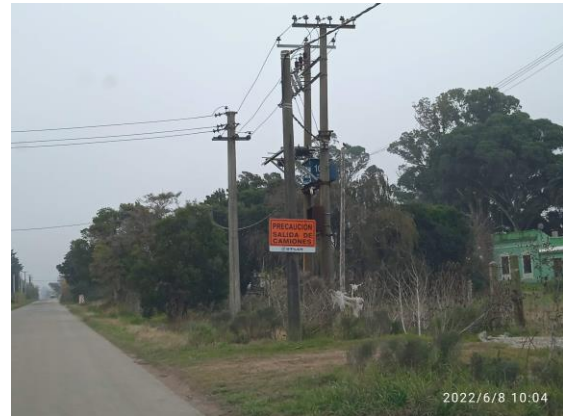
Ilustración 13 – P03, Obrador. Acceso a obrador. Correcta señalización en caminería de acceso.
