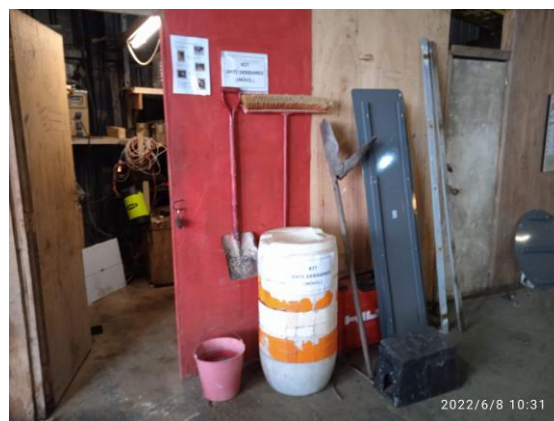
Ilustración 7 – P03, Obrador. Kit antiderrame para frente de obra.
