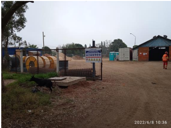
Ilustración 12 – P03, Obrador. Obrador de otro contrato de la empresa, que comparte predio con obrador de ampliación de contrato M63. Correcta señalización y separación.
