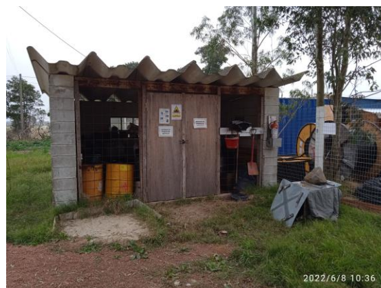
Ilustración 9 – P03, Obrador. Depósito de productos químicos y residuos especiales.
