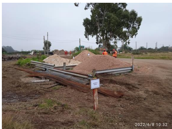
Ilustración 8 – P03, Obrador. Acopio de hierro. Debidamente señalado.
