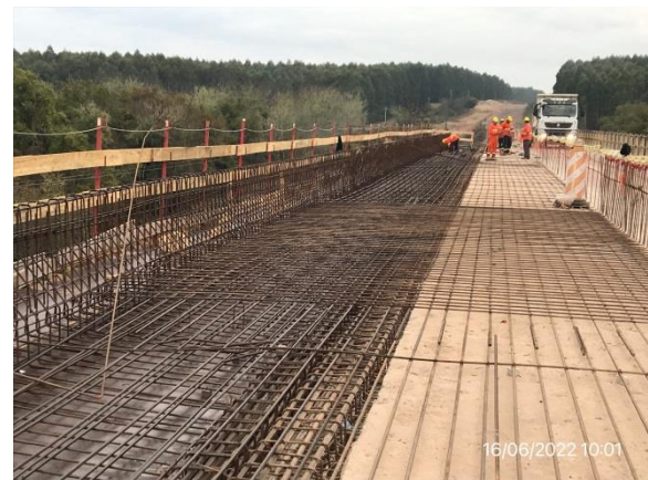
Ilustración 13 – P02, Puente sobre A° Don Esteban. Ensanche de tablero en construcción. No hay infraestructura para gestión de residuos.
