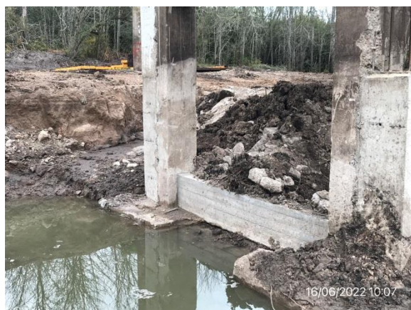
Ilustración 14 – P02, Puente sobre A° Don Esteban. Recreido de cimientos ejecutado.
