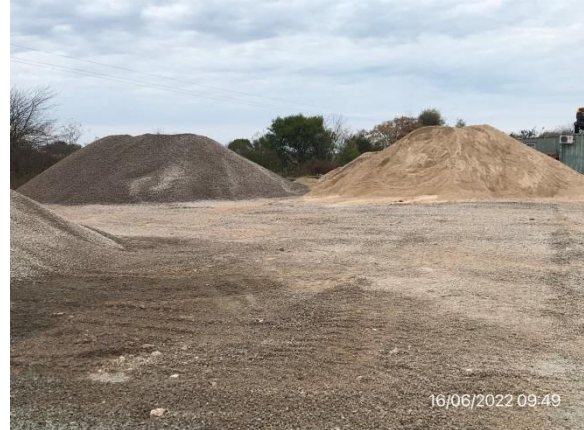
Ilustración 5 – P04, Obrador principal de Incoci SA. Explanada de acopio de áridos.
