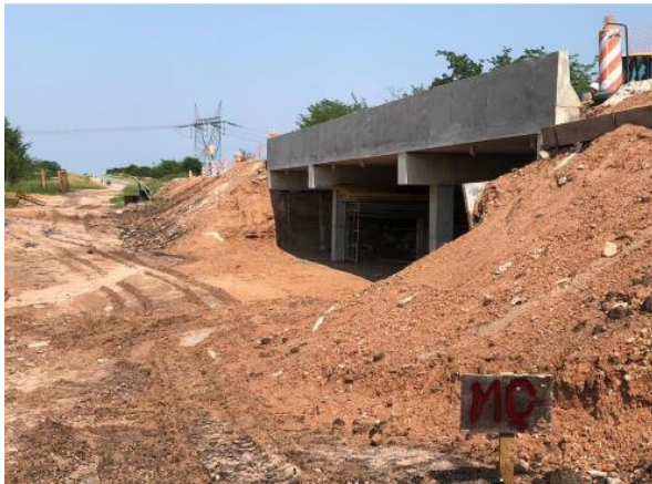
Ilustración 24 – P01, Puente sobre C da del Sauce. Ruta 20 progresiva 51K980. Zona de máxima creciente señalizada. Fotografía del 17/01/2022 proporcionada por INCOCI.
