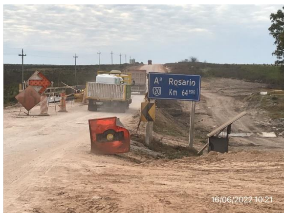
Ilustración 18 – P03, puente sobre C da del Rosario. Ruta 20, progresiva 64K880.
