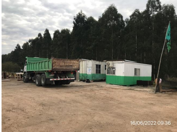
Ilustración 4 – P04, Obrador principal de Incoci SA. Ruta 20, progresiva 56K050. Vista general de explanada de estacionamiento de maquinaria.
