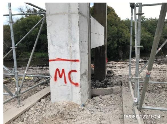
Ilustración 15 – P02, Puente sobre A° Don Esteban. Delimitación de máxima creciente.
