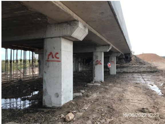
Ilustración 22 – P03, Puente sobre C da del Rosario. Tareas de recrecio de pilares culminadas.
