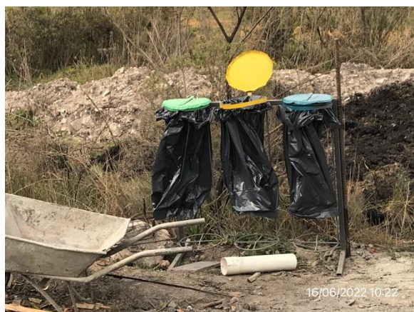
Ilustración 20 – P03, Puente sobre C da del Rosario. Estación para acopio de residuos segregados por corriente de generación.
