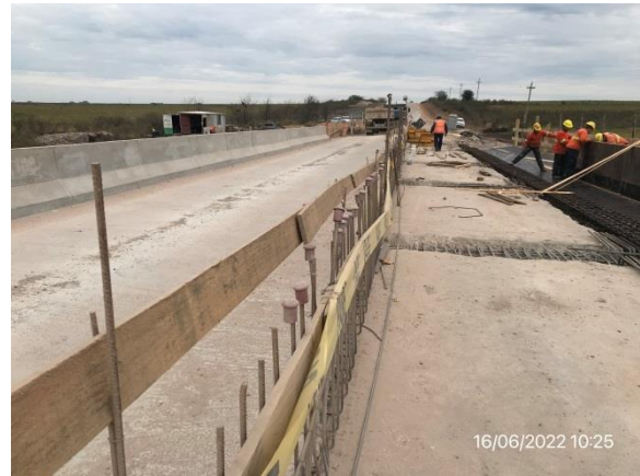
Ilustración 23 – P03, Puente sobre C da del Rosario. Tareas de ensanche de tablero en ejecución.
