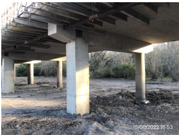
Ilustración 4 – P04. Puente sobre A° Quebracho. Obras de recrecido de pilares en ejecución.
