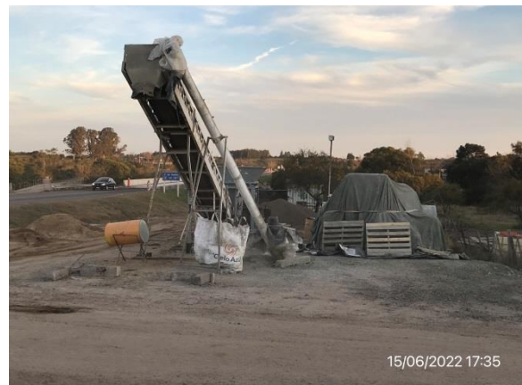
Ilustración 13 – P05 Obrador subcontratista Ingeniería Pacífico SA. Planta de hormigón.
