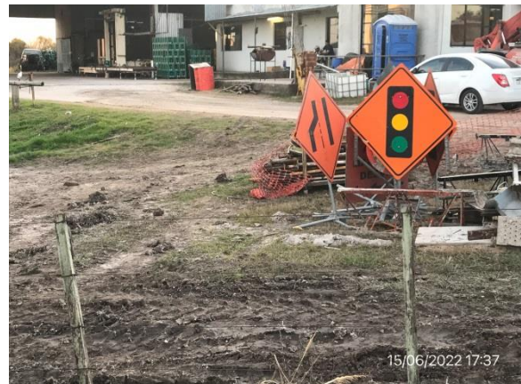
Ilustración 17 – P05 Obrador subcontratista Ingeniería Pacífico SA. Separación con tejido del resto del predio de uso privado.
