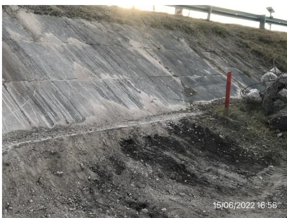
Ilustración 6 – P04. Puente sobre A° Quebracho. Zona de máxima creciente demarcada.
