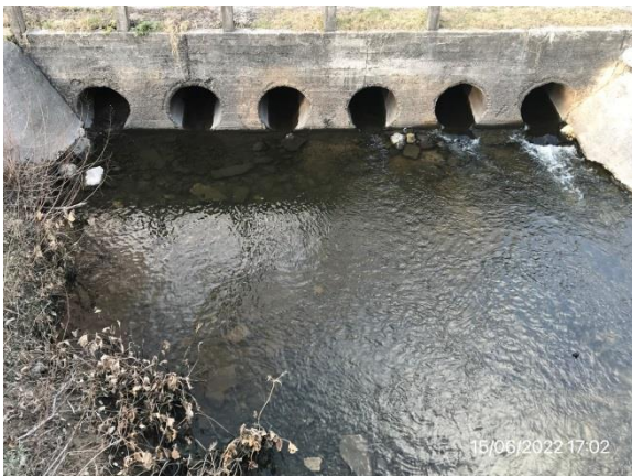
Ilustración 10 – P04. Curso de agua del A° Quebracho limpio.
