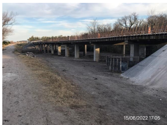
Ilustración 7 – P04. Puente sobre A° Quebracho. Explanada de trabajo limpia y ordenada.
