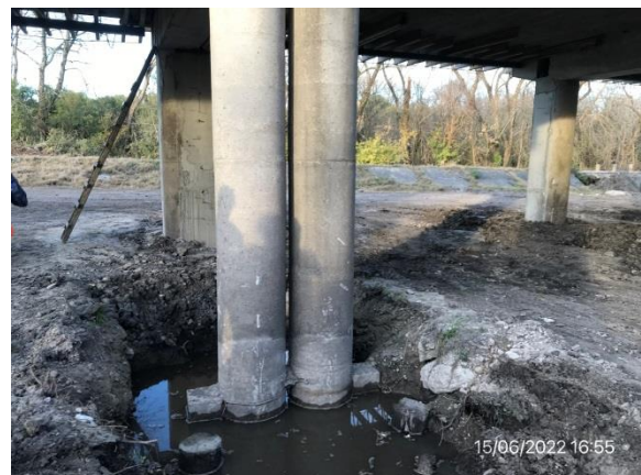
Ilustración 5 – P04. Puente sobre A° Quebracho. Recreido de cimientos en ejecución.
