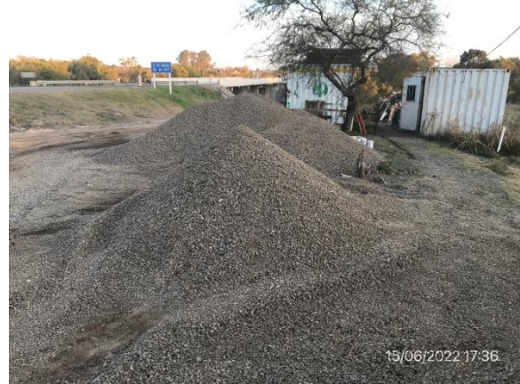
Ilustración 15 – P05 Obrador subcontratista Ingeniería Pacífico SA. Explanada de acopio de áridos.
