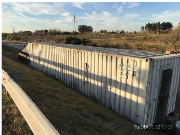
Ilustración 12 – P04, Campamento provisorio del Puente sobre A° Quebracho. Contenedor para oficinas y servicios de bienestar de operarios.
