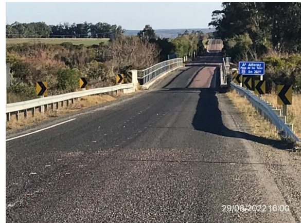
Ilustración 5 – P01, inicio de tramo. Ruta 13. Acceso este a puente sobre A° Alférez.
