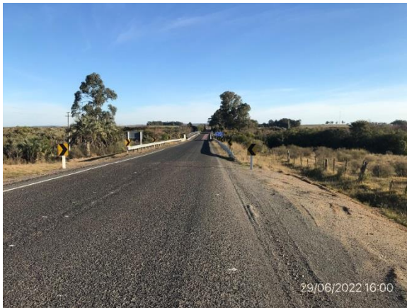
Ilustración 4 – P01, inicio de tramo. Ruta 13. progresiva 202K650
