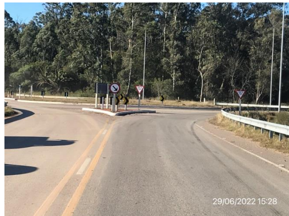
Ilustración 11 – P02, fin de tramo. Ruta 13, progresiva 218K300. Empalme con Ruta 15.
