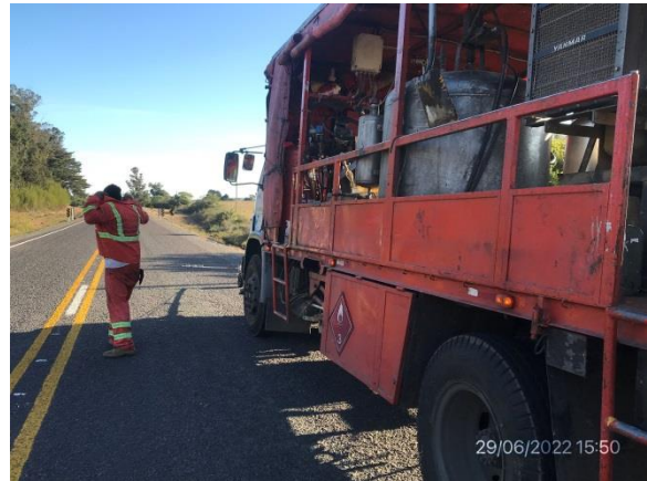
Ilustración 9 – P04, frente de Obras. Ruta 13, progresiva 209K500. Tareas de demarcación horizontal en ejecución, subcontratista Bordonix SA.
