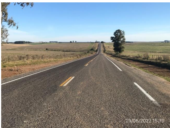
Ilustración 6 – Ruta 13. Carpeta de rodadura terminada,
