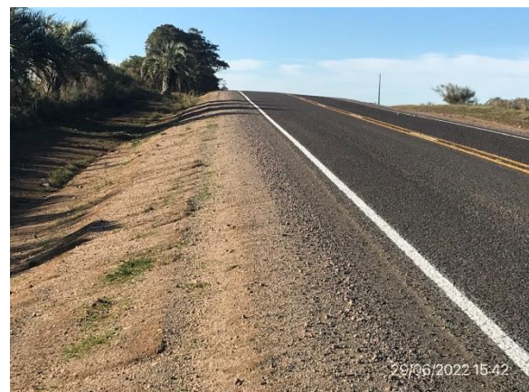
Ilustración 7 – Ruta 13. Taludes de cunetas perfilados con tapiz vegetal en crecimiento.
