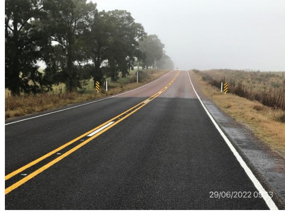
Ilustración 5 – P01. Inicio de tramo. Ruta 8, progresiva 429K000.
