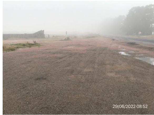
Ilustración 11 – P03. Campamento provisorio desmontado. Ruta 8, progresiva 436K800 a (-). Mejoras en plataforma acondicionada a beneficio de DNV-MTOP.
