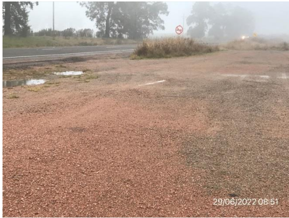
Ilustración 10 – P03. Campamento provisorio desmontado. Ruta 8, progresiva 436K800 a (-). Explanada libre de residuos.
