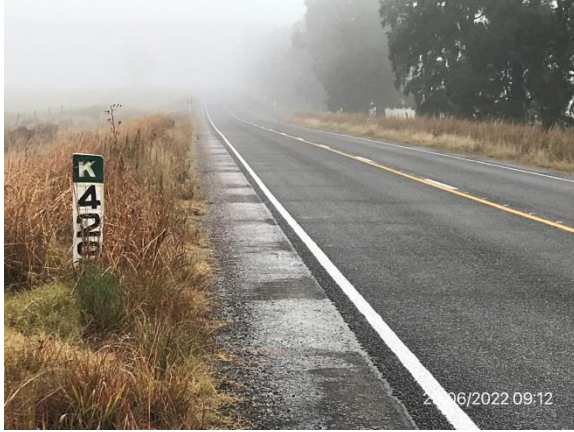
Ilustración 4 – P01. Inicio de tramo. Ruta 8, progresiva 429K000.
