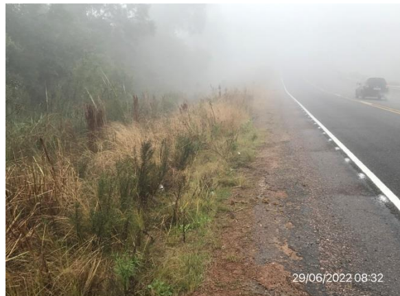
Ilustración 7 – Ruta 8. Talud de la faja pública con tapiz vegetal.
