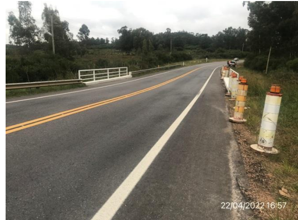
Ilustración 5 – P07, Ensanche de alcantarilla sobre Cañada del Encanto terminado
