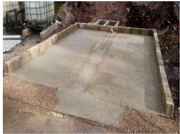
Ilustración 19 – P04, Obrador y Planta asfáltica, desmontados Padrón N° 31228. Pileta de lavado de camiones, fotografía remitida por la empresa el 04/10/2021.
