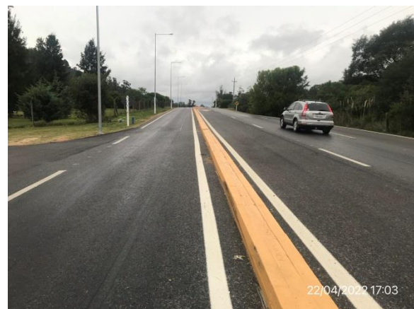
Ilustración 7 – Ruta 37, trabajos de ensanche y recapado terminados.
