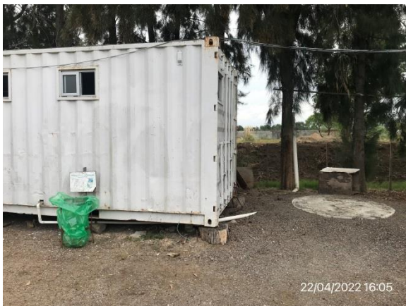
Ilustración 12 – P05, Obrador subcontratista Lemiro P. Pietroboni SA. Depósito impermeable para aguas servidas.
