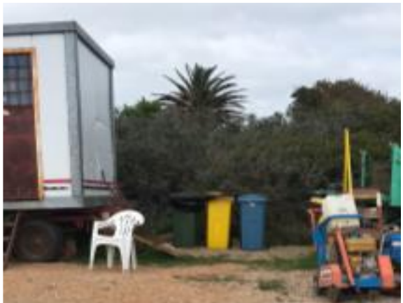
Ilustración 20 – P03, Campamento provisorio desmontado, faja pública de Ruta 37. Nueva estación de acopio de residuos, fotografía remitida por la empresa el 04/10/2021.
