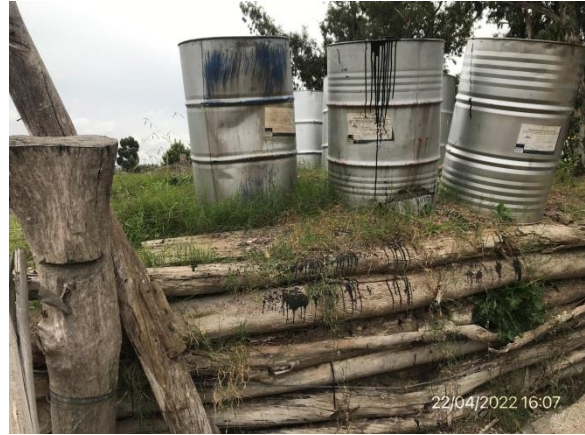
Ilustración 17 – P05, Obrador subcontratista Lemiro P. Pietroboni SA. Tarrinas de emulsiones asfálticas apoyadas en suelo desnudo.
