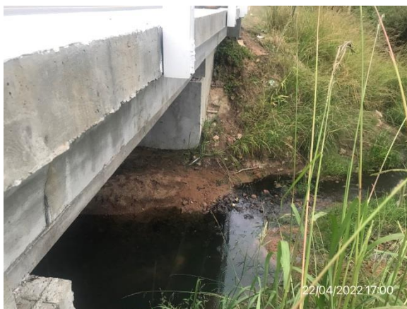
Ilustración 6 – P07, Ensanche de alcantarilla sobre Cda. del Encanto terminado, curso de agua limpio.
