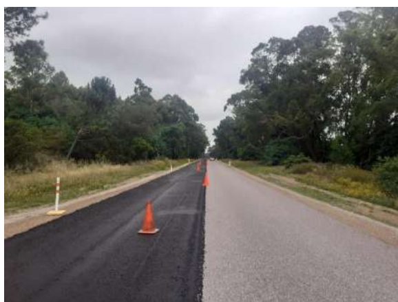
Ejecución de lechada asfáltica en Ruta 12
