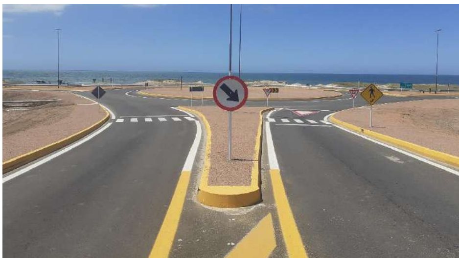
Finalización de la construcción de Rotonda Intersección Rutas 10 y 104
