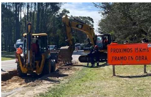
Trabajos de bacheo con tosca, recargo y reciclado la base existente en Ruta 12
