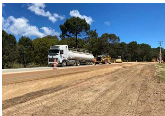
Trabajos de bacheo con tosca, recargo y reciclado la base existente en Ruta 12
