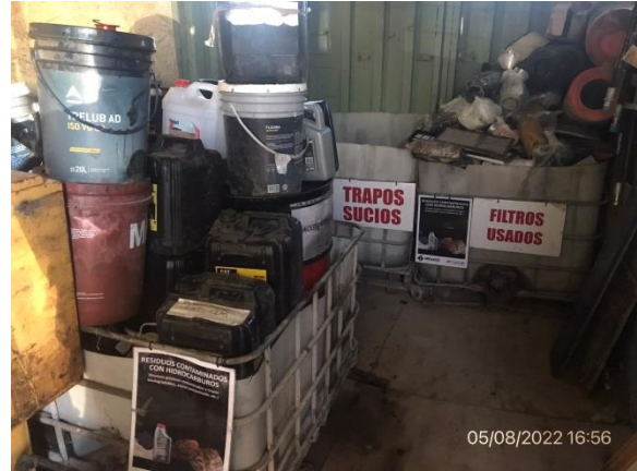
Ilustración 5 – P03, Obrador. Infraestructura envallada para acopio de lubricantes usados y otros residuos peligrosos.
