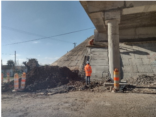
Ilustración 8- Faja pública por debajo de vía férrea 250K460.
