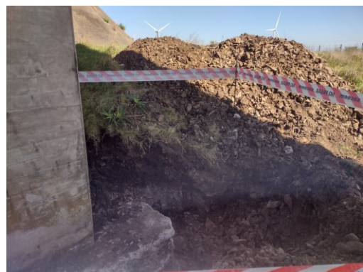
Ilustración 19- Frente de obra SACEEM 319K270
