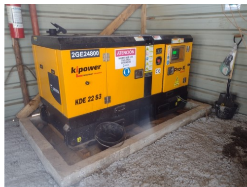
Ilustración 23- Obrador CIEMSA, almacenamiento de productos químicos, ruta 5, 309K100 a (+)
