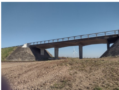
Ilustración 18- Frente de obra SACEEM 319K270
