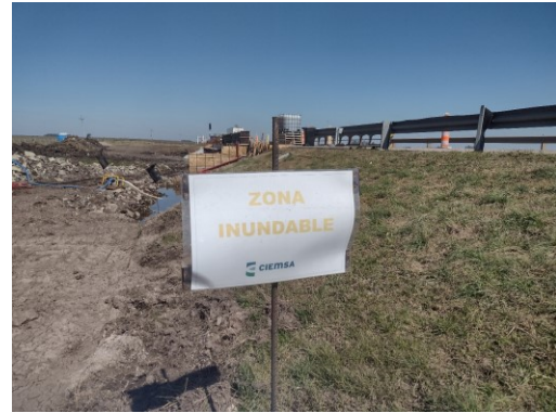
Ilustración 29- Frente de obra arroyos Salsipuedes y Zanja Honda, CIEMSA ruta 5, 308K900-310K110
