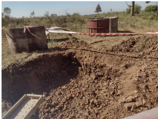
Ilustración 16- Obrador SACEEM. Excavación para pozo séptico 319K270
