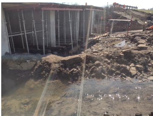
Ilustración 30- Frente de obra arroyos Salsipuedes y Zanja Honda, CIEMSA ruta 5, 308K900-310K110
