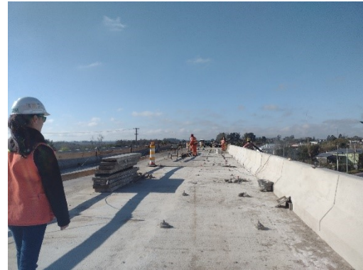
Ilustración 9- Puente sobre vía férrea 250K460.
