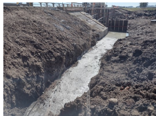
Ilustración 31- Frente de obra arroyos Salsipuedes y Zanja Honda, CIEMSA ruta 5, 308K900-310K110
