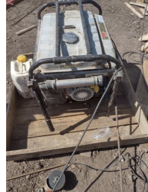
Ilustración 27- Frente de obra arroyos Salsipuedes y Zanja Honda, CIEMSA ruta 5, 308K900-310K110
