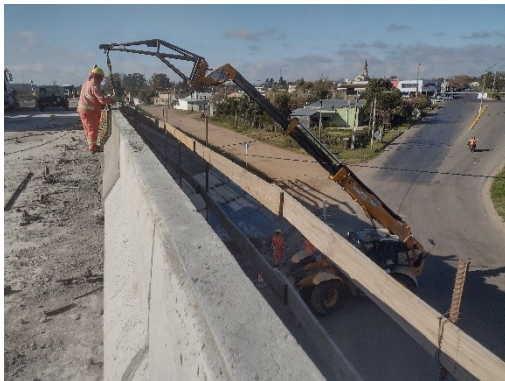
Ilustración 10- Puente sobre vía férrea 250K460.
