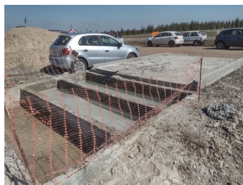
Ilustración 25- Obrador CIEMSA, piletas de lavado de hormigón, ruta 5, 309K100 a (+)
