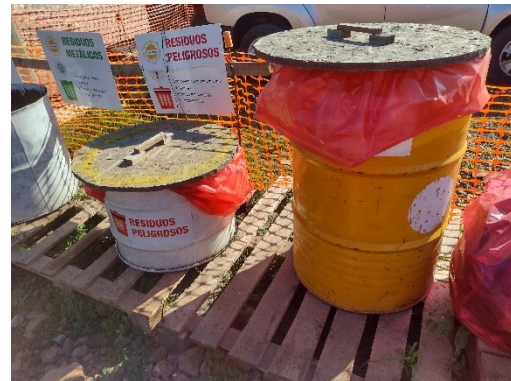
Ilustración 11- Clasificación y almacenamiento de residuos en obrador SACEEM 250K460
