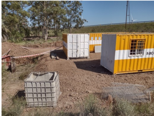
Ilustración 14- Obrador en proceso de instalación. SACEEM 319K270
