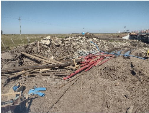
Ilustración 28- Frente de obra arroyos Salsipuedes y Zanja Honda, CIEMSA ruta 5, 308K900-310K110
