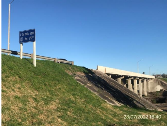
Ilustración 4 – P01, Puente sobre A° San Francisco Grande. Vista general.
