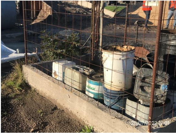
Ilustración 22 – P05, Obrador subcontratista Ingeniería Pacífico SA. Recinto techado y enmallado para aceites y lubricantes
