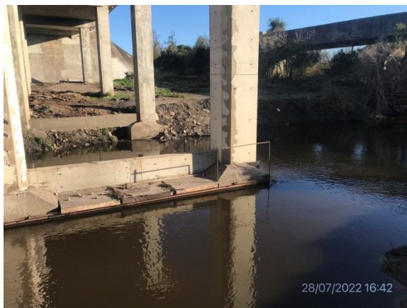
Ilustración 6 – P01, Puente sobre A° San Francisco Grande. Curso de agua limpio sin restos de obra.
