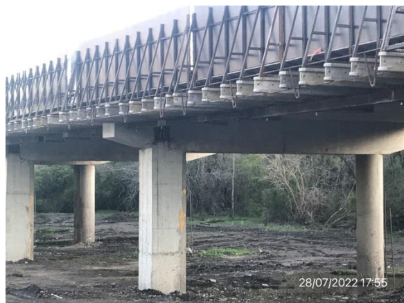
Ilustración 15 – P04, Puente sobre A° Quebracho. Recrecido de pilares en media calzada ejecutado.
