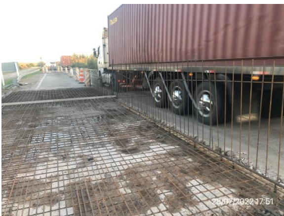
Ilustración 14 – P04, Puente sobre A° Quebracho. Trabajos de recrecido en media calzada en ejecución.
