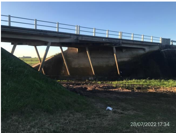
Ilustración 12 – P03, Pasaje superior sobre vía férrea, Ruta 3 progresiva 403K480. Obras sin comenzar.
