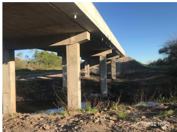
Ilustración 9 – P02, Puente sobre A° San Francisco Chico. Obras de recredido de pórticos terminadas. Tablero superior con trabajos parcialmente terminados.
