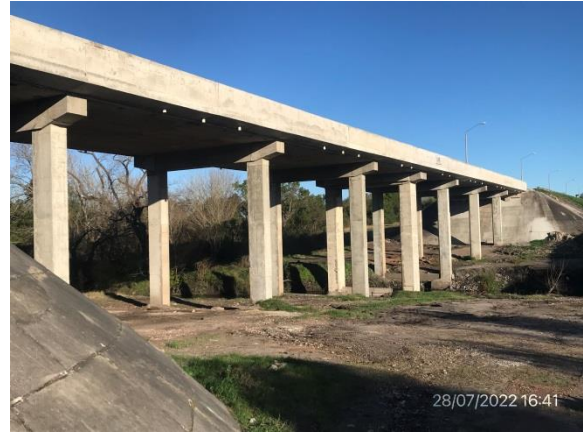
Ilustración 5 – P01, Puente sobre A° San Francisco Grande. Obras terminadas de ensanchado de tablero y pilares
