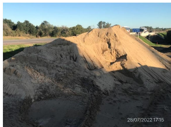
Ilustración 21 – P05, Obrador subcontratista Ingeniería Pacífico SA. Explanada de acopio de áridos.
