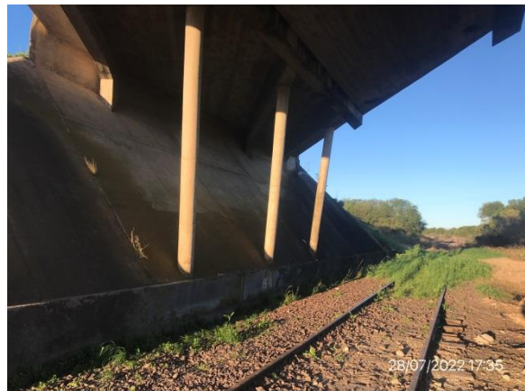
Ilustración 13 – P03, Pasaje superior sobre vía férrea, Ruta 3 progresiva 403K480. Obras sin comenzar.
