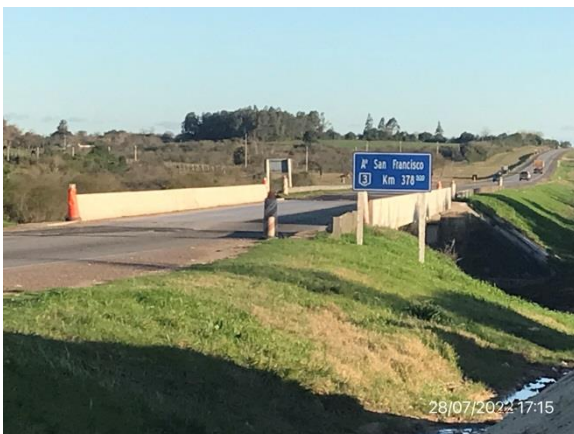
Ilustración 8 – P02, Puente sobre A° San Francisco Chico. Vista general.
