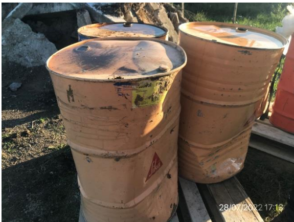
Ilustración 24 – P05, Obrador subcontratista Ingeniería Pacífico SA. Productos químicos fuera de recinto impermeable
