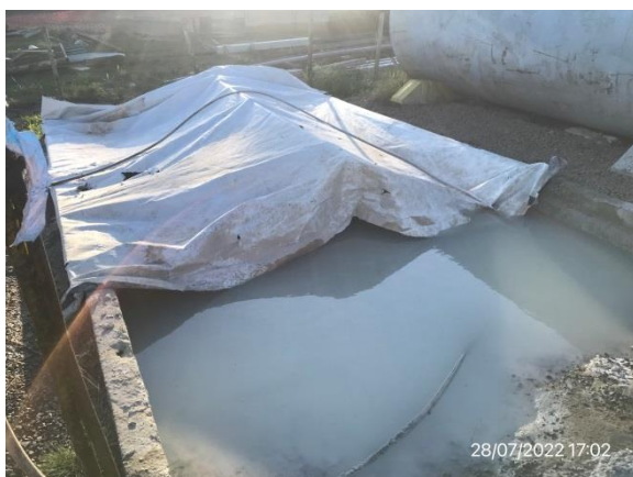
Ilustración 20 – P05, Obrador subcontratista Ingeniería Pacífico SA. Pileta de lavado de camión mixer
