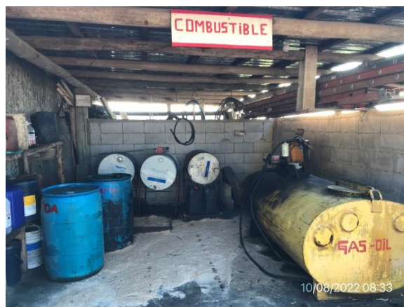
Ilustración 11 – P05, Obrador subcontratista Lemiro Pietroboni SA, Depósito de combustibles y lubricantes techado y con envallado perimetral y pavimento impermeable.
