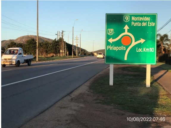
Ilustración 4 – P03, Inicio de tramo de obras. Ruta 9, progresiva 105K650. Planta urbana de Pan de Azúcar. Obras terminadas.
