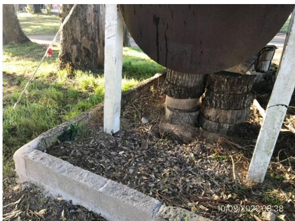
Ilustración 14 – P05, Obrador subcontratista Lemiro Pietroboni SA, Depósito de emulsiones asfálticas con envallado perimetral reparado y en condiciones adecuadas.
