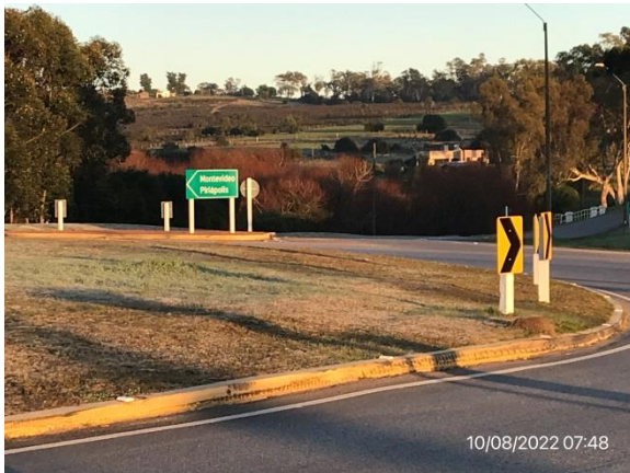
Ilustración 6 – P03, Inicio de tramo de obras. Ruta 9, progresiva 105K650. Planta urbana de Pan de Azúcar. Obras terminadas, empastado en proceso.
