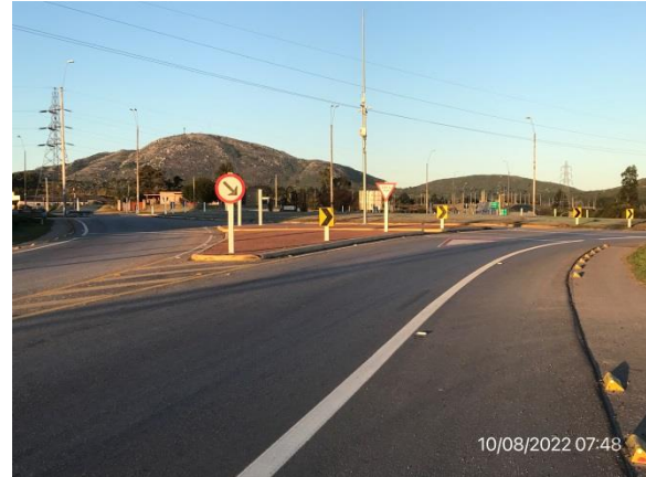
Ilustración 5 – P03, Inicio de tramo de obras. Ruta 9, progresiva 105K650. Planta urbana de Pan de Azúcar. Obras terminadas.
