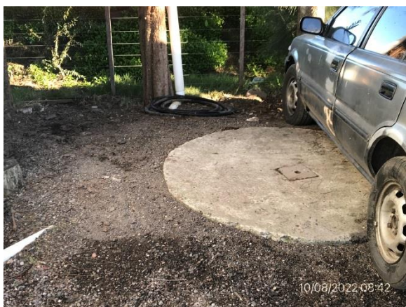
Ilustración 10 – P05, Obrador subcontratista Lemiro Pietroboni SA, Depósito impermeable para aguas servidas.
