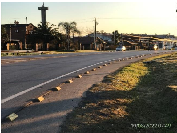
Ilustración 8 – P04, Fin de tramo de obras. Ruta 9, progresiva 106K450. Planta urbana de Pan de Azúcar. Obras terminadas, empastado en proceso.
