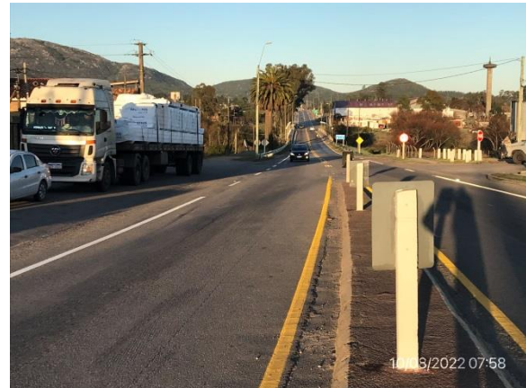
Ilustración 7 – P04, Fin de tramo de obras. Ruta 9, progresiva 106K450. Planta urbana de Pan de Azúcar. Obras terminadas.
