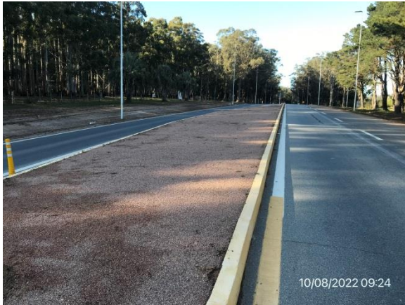
Ilustración 10 – P04, Nuevo acceso a museo Fundación Atchugarry. Ruta 104 progresiva 4K600. Obras terminadas.
