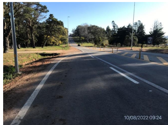
Ilustración 9 – P04, Nuevo acceso a museo Fundación Atchugarry. Ruta 104 progresiva 4K600. Obras terminadas.
