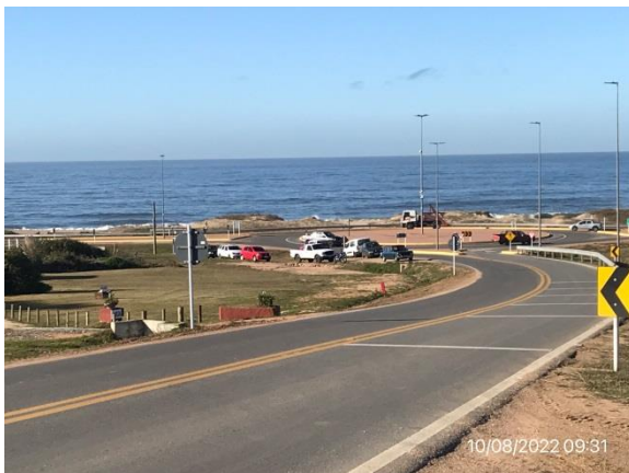
Ilustración 6 – P03, Nueva rotonda en empalme de rutas 10 y 104. Obras de iluminación terminadas.
