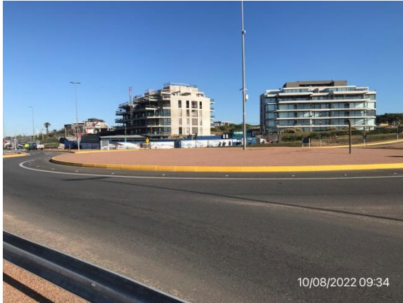
Ilustración 4 – P03, Nueva rotonda en empalme de rutas 10 y 104. Obras terminadas.
