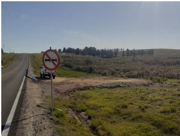
Ilustración 12 – Ruta 12, progresiva 14K400. Evidencias de acopio de material granular retirado. Imagen proporcionada por la empresa el 22/04/2022.
