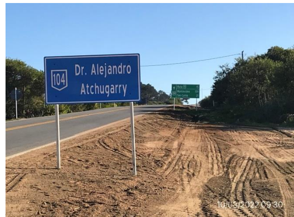
Ilustración 7 – P03, Campamento provisional desmontado, faja pública de Ruta 10, progresiva 164K800. Mejoras quedan para uso de DNV/MTOP.
