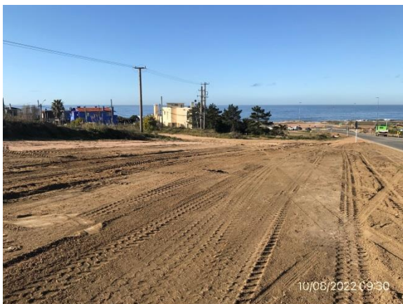
Ilustración 8 – P03, Campamento provisional desmontado, faja pública de Ruta 10, progresiva 164K800. Mejoras quedan para uso de DNV/MTOP
