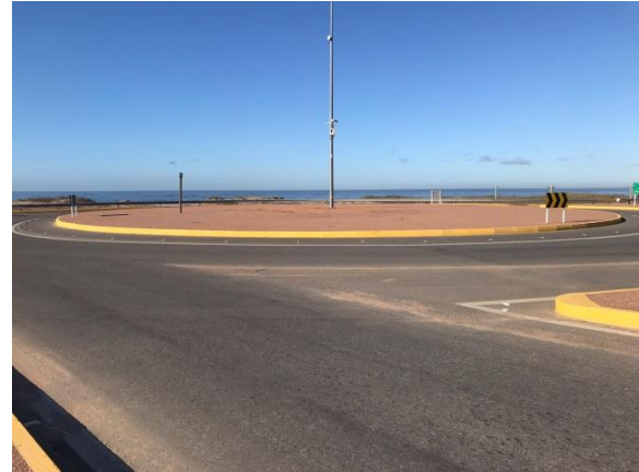
Ilustración 5 – P03, Nueva rotonda en empalme de rutas 10 y 104. Obras terminadas.
