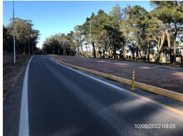
Ilustración 11 – P04, Nuevo acceso a museo Fundación Atchugarry. Ruta 104 progresiva 4K600. Obras terminadas.
