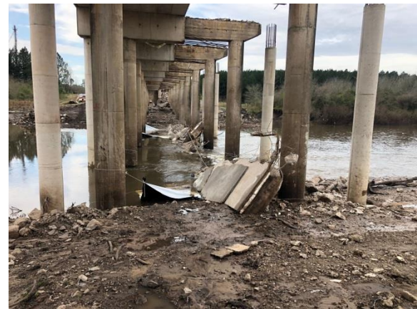
Ilustración 7 – P01, Puente sobre río Tacuarembó Chico. Restos de demolición de tablero sobre lecho del cauce. Imagen proporcionada por el DDO el 26/07/2022.
