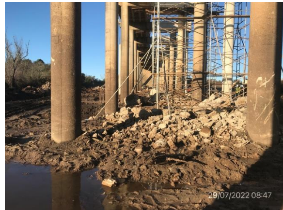
Ilustración 23 – P03, Puente sobre río Tacuarembó Grande, Demoliciones avanzando en sector on shore.
