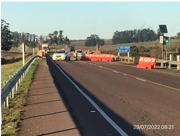
Ilustración 12 – P02, Puente sobre A° Tres Cruces. Tránsito en media calzada.
