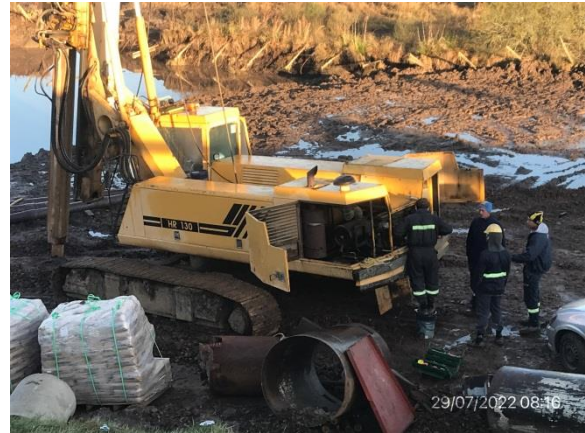
Ilustración 17 – P02, Puente sobre A° Tres Cruces. Equipo de pilotaje de Costa Fortuna SA.
