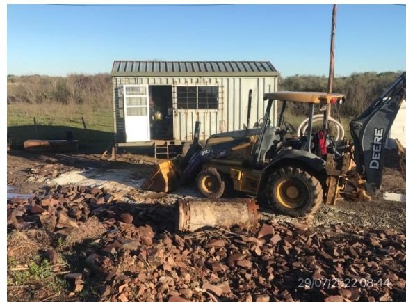
Ilustración 25 – P03, Puente sobre río Tacuarembó Grande. Campamento provisorio.
