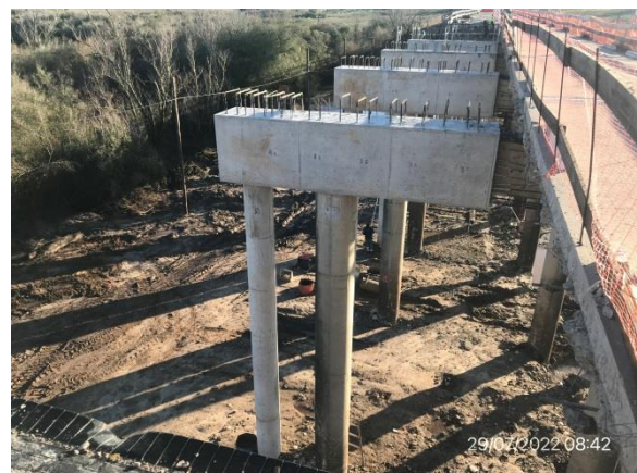
Ilustración 21 – P03, Puente sobre río Tacuarembó Grande. Nuevos pilares ejecutados y pórticos ampliados.
