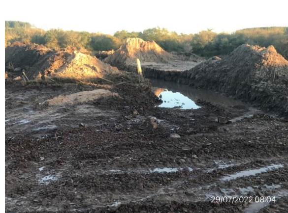
Ilustración 15 – P02, Puente sobre A° Tres Cruces. Excavación con destino a préstamo para ataguía en padrón N° 10273, 5ª SC. Catastral de Tacuarembó. No cuenta con AAP ni AAO.
