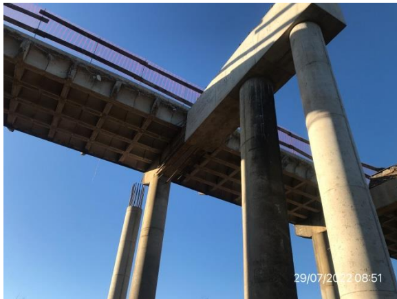
Ilustración 22 – P03, Puente sobre río Tacuarembó Grande. Nuevos pilares ejecutados y pórticos ampliados.
