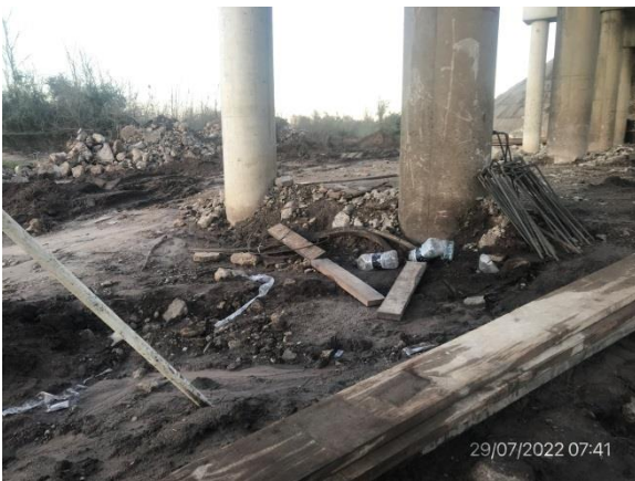
Ilustración 8 – P01, Puente sobre río Tacuarembó Chico. Residuos de obra civil mezclados con residuos plásticos en planicie inundable. No hay infraestructura para gestión de residuos.
