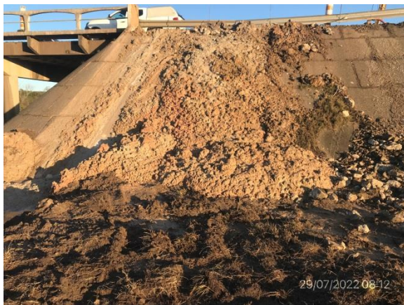
Ilustración 18 – P02, Puente sobre A° Tres Cruces. Acopio de arenas mezcladas con bentonita dispuesta sobre terreno natural. Tránsito en media calzada.
