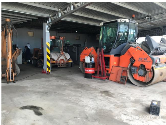
Ilustración 8 – P04, Obrador. Taller de reparación de maquinaria techado y con pavimento impermeable
