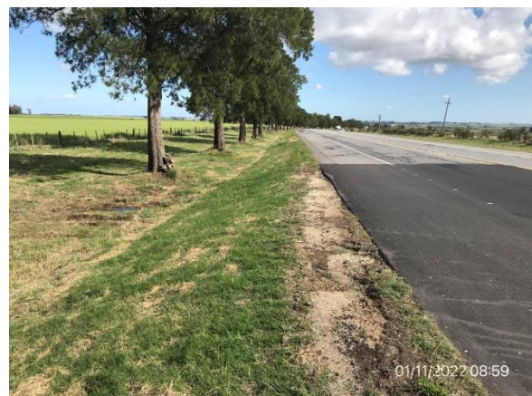
Ilustración 21 – Obras de mantenimiento terminadas en Ruta 3. Remediación correcta de tapiz vegetal.
