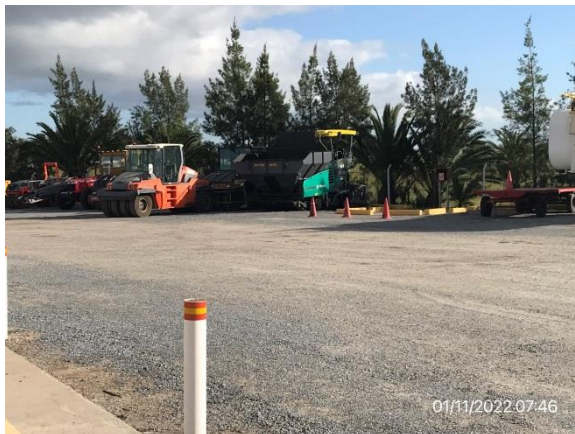
Ilustración 6 – P04, Obrador. Explanada de maniobras.
