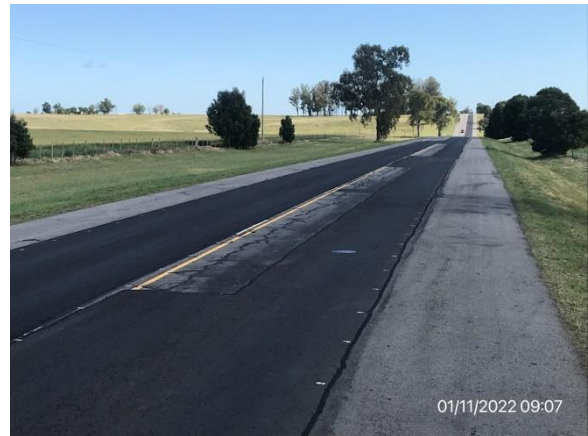
Ilustración 19 – Obras de mantenimiento terminadas, bacheo en Ruta 3.
