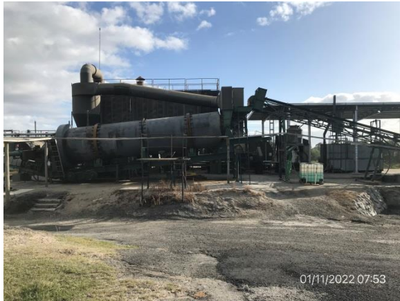
Ilustración 10 – P04, Obrador. Planta asfáltica en tareas de mantenimiento.
