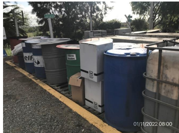
Ilustración 13 – P04, Obrador. Sector de acopio de aceites usados y tierras contaminadas con envallado perimetral.
