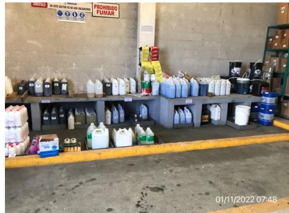
Ilustración 7 – P04, Obrador. Sector envaseado, techado y con pavimento impermeable para acopio de lubricantes y otros productos químicos.
