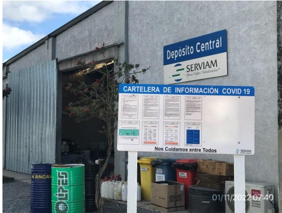
Ilustración 4 – P04, Obrador. Estación para acopio de residuos de forma segregada por corriente de generación.
