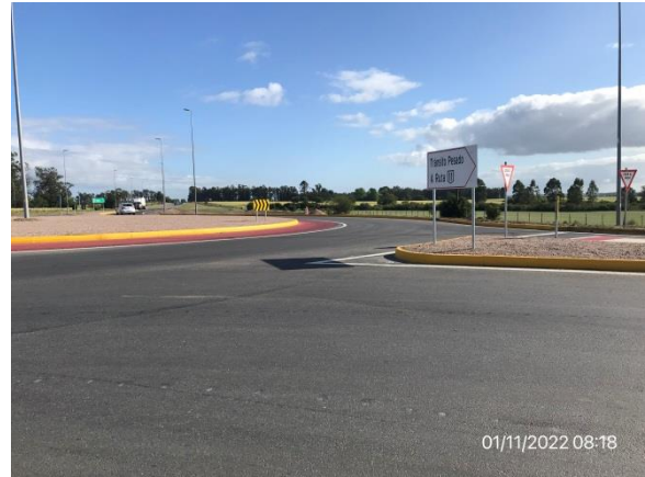
Ilustración 17 – P03, Rotonda terminada. Carpeta de rodadura y obras de señalización ejecutadas.
