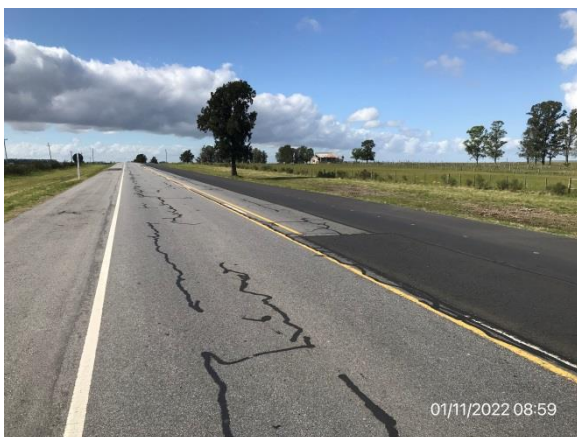
Ilustración 20 – Obras de mantenimiento terminadas, sellado de fisuras en Ruta 3.
