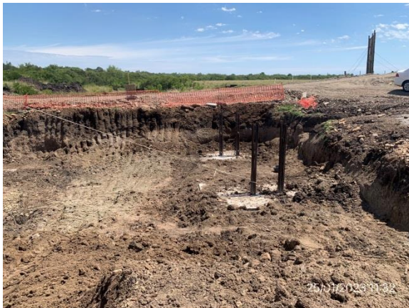
Ilustración 12 – P01, puente sobre A° Tres Árboles. Cimientos en construcción. No hay infraestructura para acopio de residuos en las proximidades del frente de obras.
