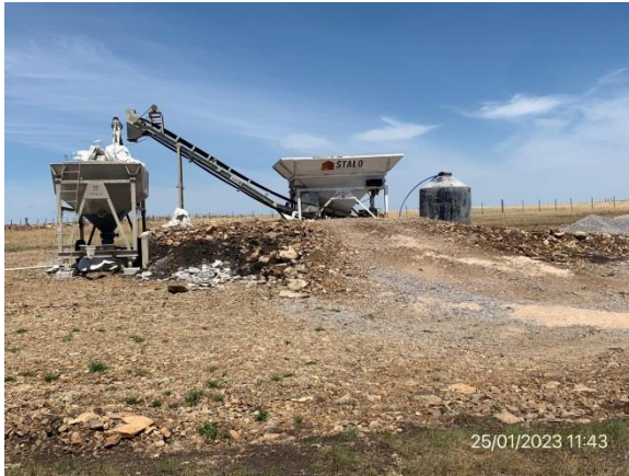
Ilustración 10 – P01, obrador principal. Planta de hormigón.
