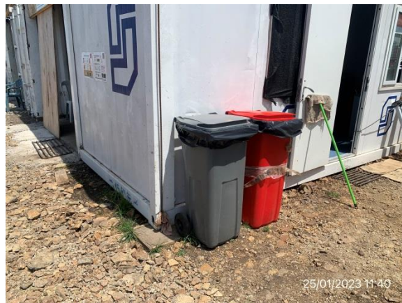
Ilustración 5 – P01, obrador principal. Estación de acopio de residuos por canal de generación.
