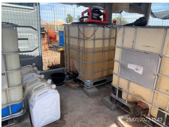
Ilustración 8 – P01, obrador principal. Sector cubierto, envallado y con pavimento impermeable para acopio de lubricantes y residuos peligrosos
