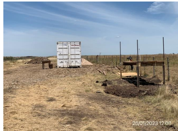
Ilustración 15 – P02, puente sobre A° Isla de Argüello. Campamento provisorio.
