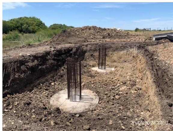
Ilustración 19 – P02, puente sobre A° Isla de Argüello. Construcción de cimientos en proceso.
