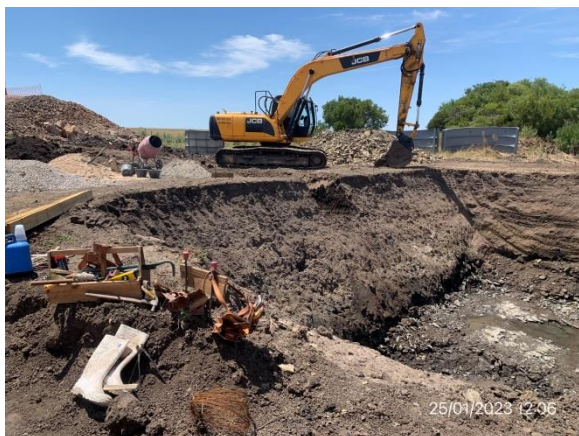
Ilustración 18 – P02, puente sobre A° Isla de Argüello. Excavaciones de cimientos en proceso con maquinaria pesada, sin que en el campamento provisorio existan elementos para prevención de incidentes.
