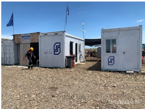
Ilustración 4 – P01, obrador principal. Oficinas y explanada de maniobras.
