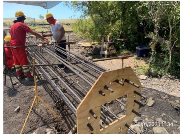
Ilustración 11 – P01, obrador principal. Taller de herrería y de fabricación de armaduras.
