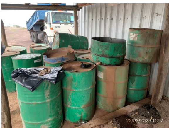
Ilustración 14 – P03, Obrador central. Depósito de lubricantes usados con envallado perimetral.
