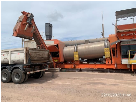
Ilustración 10 – P03, Obrador central. Planta asfáltica en funcionamiento.
