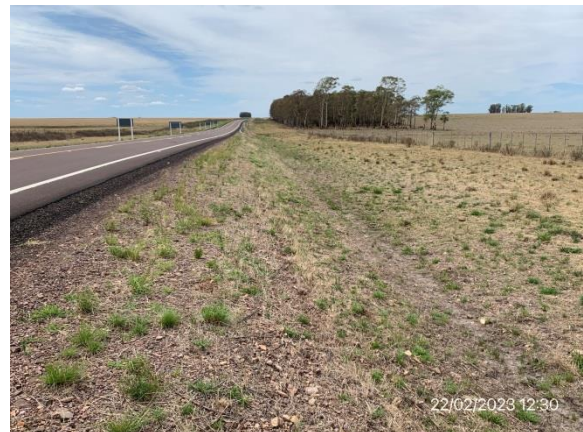
Ilustración 7 – Ruta 43, obras terminadas. Sector de faja pública con recuperación ambiental realizada, drenaje correcto y empastado en proceso.
