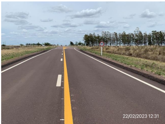
Ilustración 6 – Ruta 43, obras terminadas. Trabajos de adecuación y señalización terminados.
