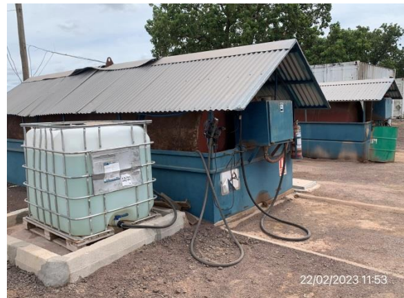
Ilustración 13 – P03, Obrador central. Estación de combustible con envallado perimetral impermeable y techo.
