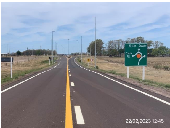
Ilustración 8 – P02, Fin de tramo de obras en Ruta 43.
