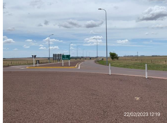
Ilustración 5 – P01, Inicio de tramo de obras en Ruta 43. Empalme de Ruta 43 y Ruta 5.
