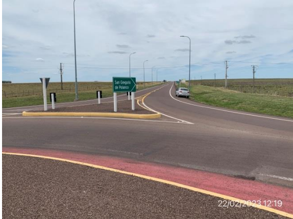
Ilustración 4 – P01, Inicio de tramo de obras en Ruta 43. Empalme de Ruta 43 y Ruta 5.
