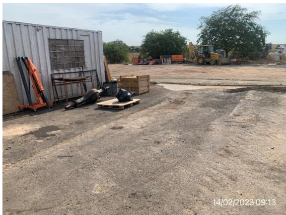
Ilustración 18 – P03, Obrador Principal. Sector de mantenimiento liviano con pavimento impermeable.
