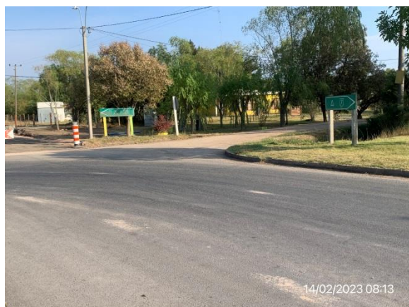
Ilustración 6 – Tramo de Ruta 81 terminado hasta ingreso a localidad de San Bautista
