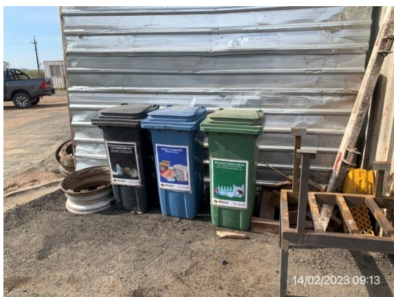
Ilustración 20 – P03, Obrador Principal. Estación de acopio de residuos segregados por corriente de generación.
