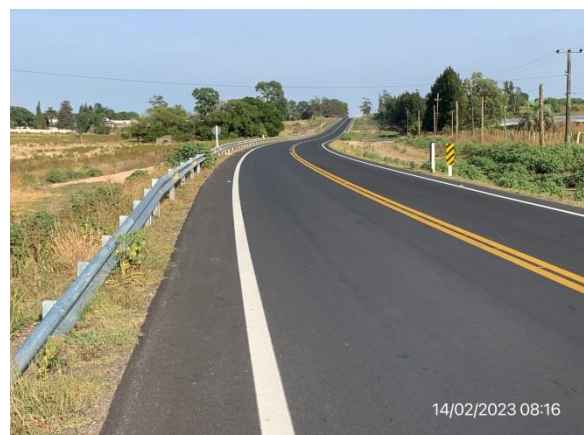
Ilustración 7 – Tramo de Ruta 81 terminado. Plataforma ensanchada y carpeta asfáltica terminada
