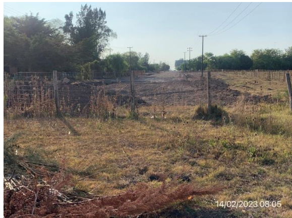
Ilustración 4 – P02, fin de tramo. Sector de 270 m. en ejecución, Ruta 81 progresiva 42K300. Empalme a construir con Ruta 6, San Bautista
