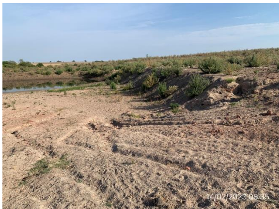
Ilustración 12 – P04, Cantera de limo. Padrón rural N°15214 12ª SC, Canelones. Ruta 81, progresiva 49K800 a (+) Taludes suavizados.
