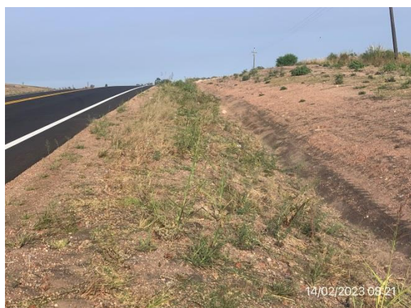
Ilustración 8 – Faja pública de Ruta 81 en condiciones adecuadas de drenaje y empastado natural
