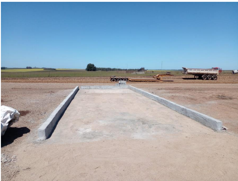
Imagen 2 – Piso impermeable para mantenimientos menores en obrador
