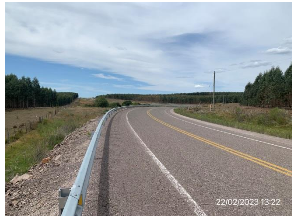
Ilustración 13 – Obras terminadas en Ruta 59. Obras de señalización culminadas.
