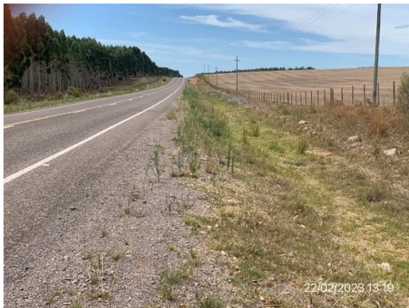
Ilustración 12 – Obras terminadas en Ruta 59. Faja pública de ruta en buenas condiciones de drenaje y con tapiz vegetal en crecimiento.
