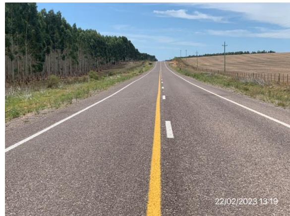
Ilustración 11 – Obras terminadas en Ruta 59. Tramo de calzada ensanchado y con nueva capa de rodadura..
