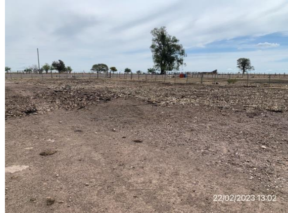
Ilustración 5 – P03, Obrador. Zona de instalaciones provisionales de contenedores libre de residuos o escombros.
