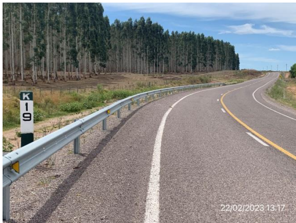
Ilustración 10 – P01, Inicio del tramo. Ruta 59, progresiva 19K380
