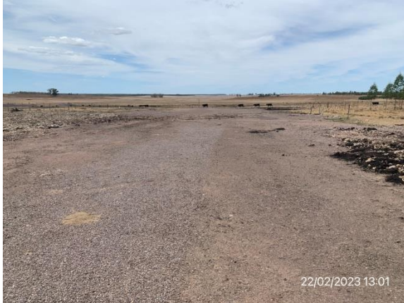
Ilustración 4 – P03, Obrador. Explanada granular para zona de maniobras, mejora en el predio a beneficio del propietario
