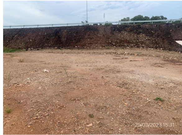
Ilustración 11 – P03, Obrador subcontratista Lipin SA libre de ROCs u otros residuos.
