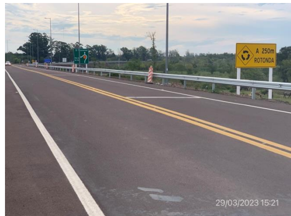
Ilustración 9 – Nuevo bypass Centenario. Obras de señalización horizontal y vertical terminadas.
