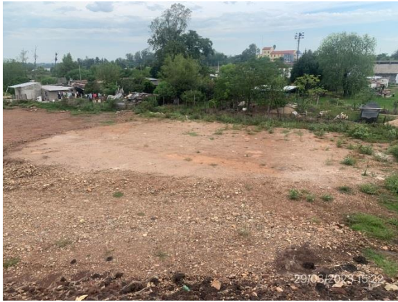
Ilustración 10 – P03, Obrador subcontratista Lipin SA desmontado, sin restos de infraestructuras provisionarias.
