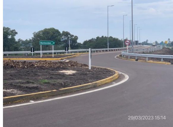
Ilustración 5 – P02, fin de tramo. Empalme de Ruta 5 con bypass Ruta 5, progresiva 250K000.
