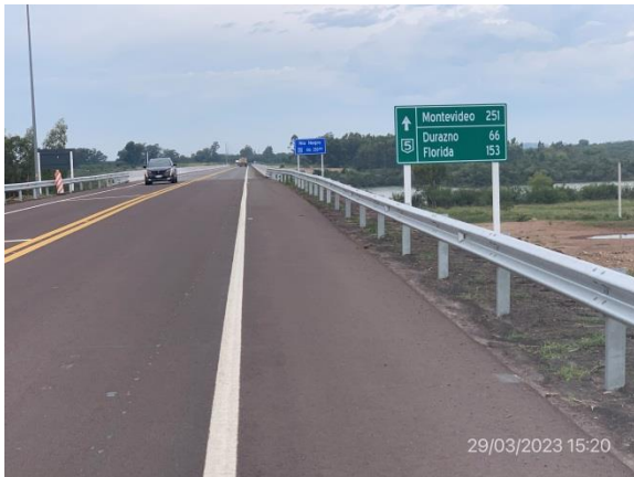
Ilustración 6 – P01, inicio de tramo. Cabecera Norte de nuevo puente sobre el río Negro.
