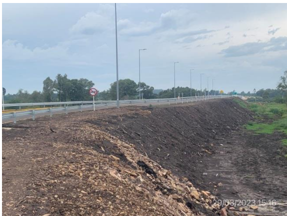
Ilustración 8 – Nuevo bypass Centenario. Obras de terraplenado, base estructural y carpeta de rodadura terminadas.
