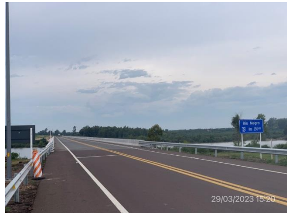
Ilustración 7 – P01, inicio de tramo. Cabecera Norte de nuevo puente sobre el río Negro.
