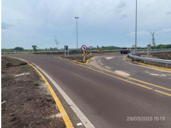
Ilustración 4 – P02, fin de tramo. Empalme de Ruta 5 con bypass Ruta 5, progresiva 250K000.
