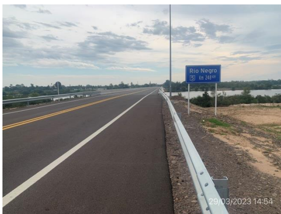
Ilustración 9 – P02, fin de tramo. Bypass Centenario, progresiva 248K600.
