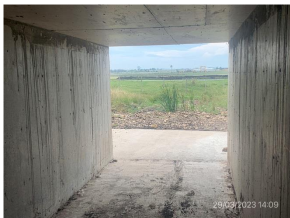
Ilustración 8 – P05, alcantarilla terminada. Bypass Centenario, progresiva 245K500.
