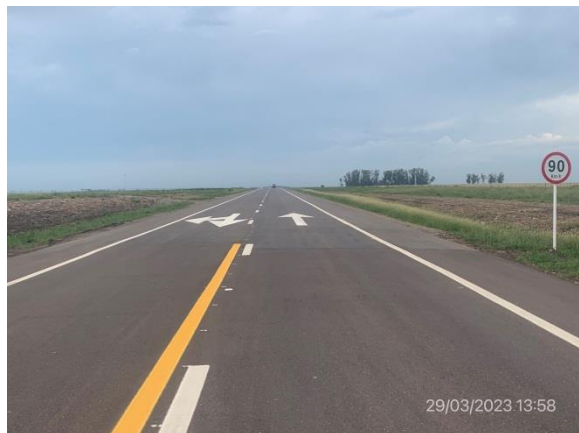
Ilustración 4 – P01, inicio de tramo. Bypass Centenario, progresiva 244K500.
