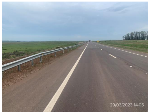
Ilustración 5 – Bypass Centenario, carpeta de rodadura en mezcla asfáltica y obras de señalización horizontal y de defensas metálicas terminadas.
