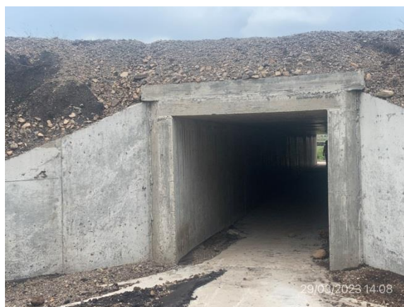
Ilustración 7 – P05, alcantarilla terminada. Bypass Centenario, progresiva 245K500.
