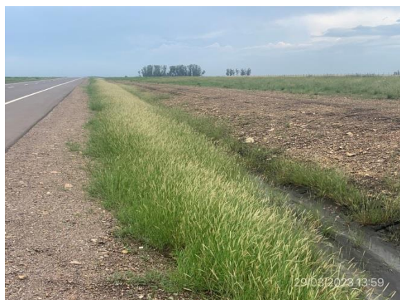
Ilustración 6 – Bypass Centenario, drenajes adecuados y tapiz vegetal en crecimiento.
