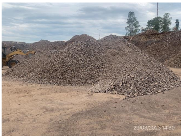
Ilustración 14 – P04, Cantera. Acopio de basalto triturado con tren primario.
