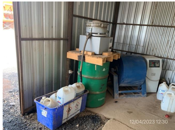
Ilustración 13 – P03, Obrador. Depósito de perclorotileno usado con doble contención plástica.
