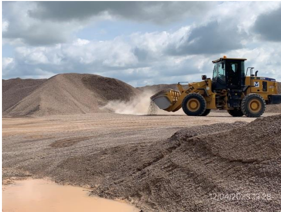
Ilustración 16 – P03, Obrador. Explanada de acopio de áridos
