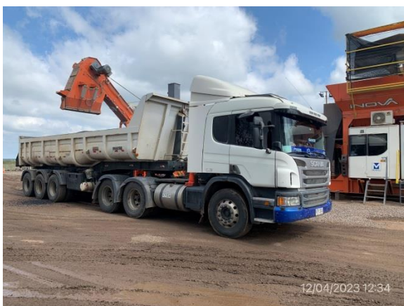
Ilustración 8 – P03. Planta asfáltica. Proceso de descarga de mezcla asfáltica en camión con cazamba.
