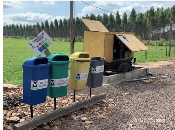
Ilustración 17 – P03, Obrador. Estación de acopio de residuos segregado por corriente de generación.
