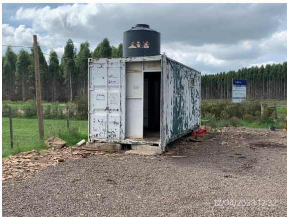
Ilustración 14 – P03, Obrador. Depósito impermeable para aguas servidas.
