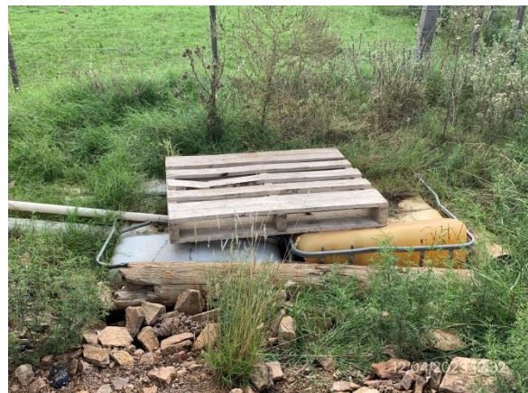
Ilustración 15 – P03, Obrador. Depósito impermeable para aguas servidas.
