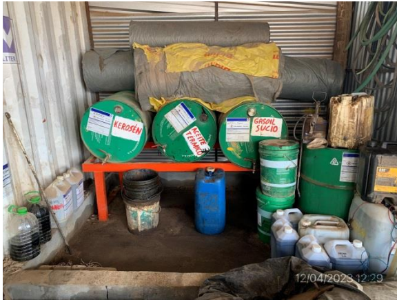
Ilustración 10 – P03, Obrador. Depósito de lubricantes en local cerrado y envallado.
