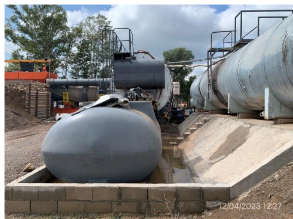
Ilustración 9 – P03. Planta asfáltica. Envallado de tarrinas de emulsión correcto.
