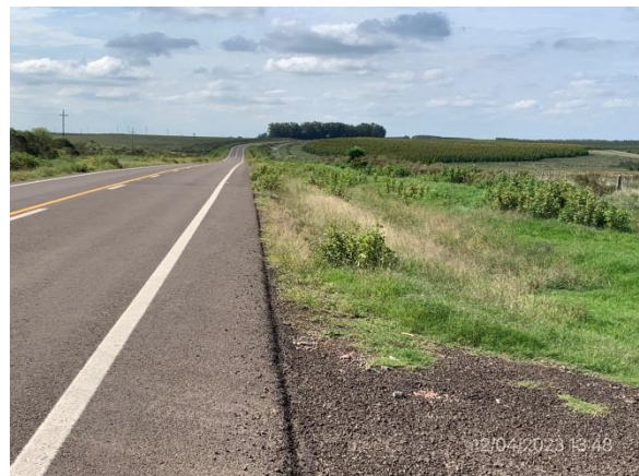
Ilustración 19 – Tramo de obra terminado con recuperación ambiental ejecutada. Carpeta de rodadura y señalización terminadas. Banquinas con empastado en crecimiento.
