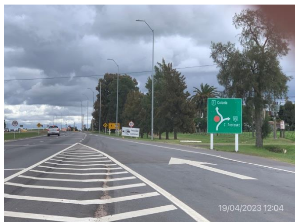
Ilustración 10 – P06, Fin de obras 1 y 2. Ruta 1 progresiva 54K400, a (+). Empalme con Ruta 45.
