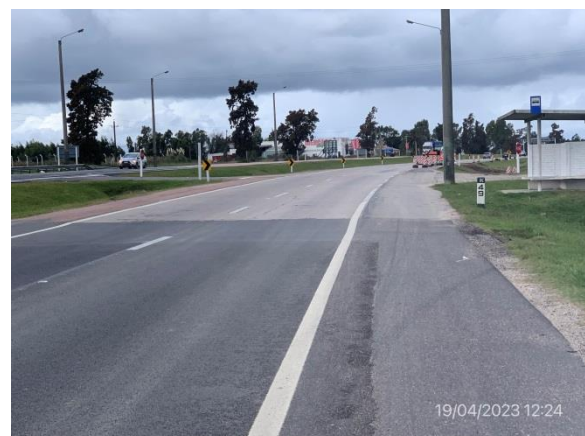
Ilustración 9 – P05, Inicio de obras 1 y 2. Ruta 1, progresiva 49K000 a (-).
