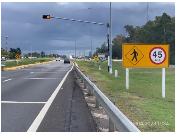
Ilustración 6 – P04, Fin de obras 3 y 4. Ruta 1, progresiva 27K000 a (+).
