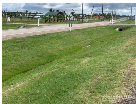
Ilustración 13 – Recuperación ambiental de faja pública de Ruta 1 ejecutada. Drenajes y cobertura vegetal adecuados.
