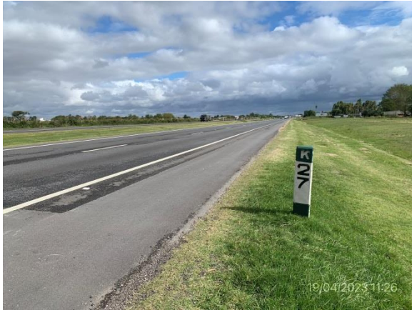
Ilustración 4 – P03, Inicio de obras 3 y 4. Ruta 1 progresiva 27K000 a (+).
