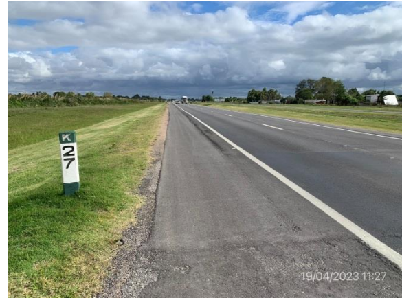
Ilustración 5 – P03, Inicio de obras 3 y 4. Ruta 1 progresiva 27K000 a (-).
