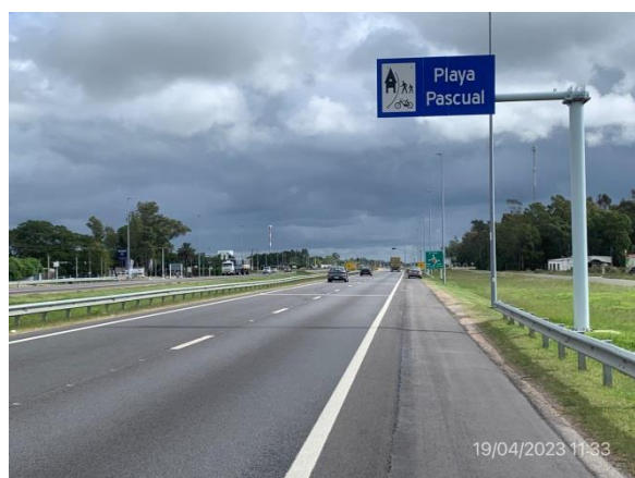
Ilustración 12 – Obras de mantenimiento terminadas en Ruta 1. Carpeta de rodadura y obras de señalización culminadas.
