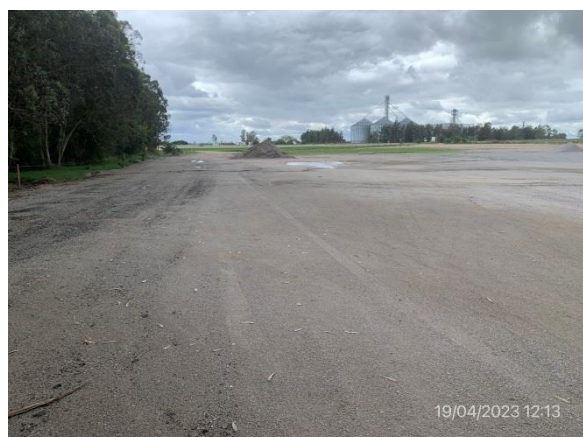
Ilustración 14 – P07. Obrador desmontado Ruta 1 progresiva, 60K100. Padrón N°7.888 (Puntas de Valdez), San José.
