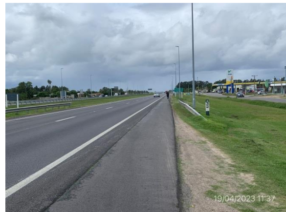
Ilustración 7 – P04, Fin de obras 3 y 4. Ruta 1, progresiva 27K000 a (-).
