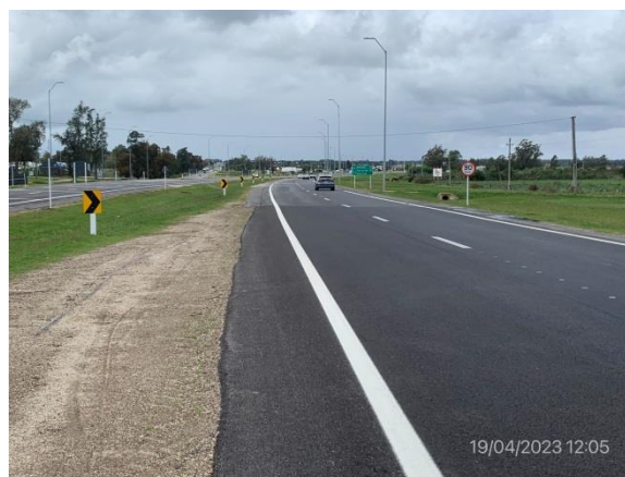
Ilustración 11 – P06, Fin de obras 1 y 2. Ruta 1 progresiva 54K400, a (-).
