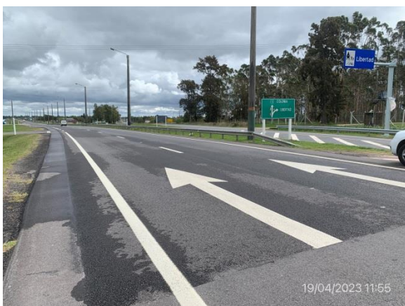
Ilustración 8 – P05, Inicio de obras 1 y 2. Ruta 1, progresiva 49K000 a (+). Acceso a Libertad.
