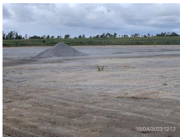
Ilustración 15 – P07, Obrador desmontado. Potenciales mejoras a beneficio del propietario: explanada de maniobras y acopio granular.
