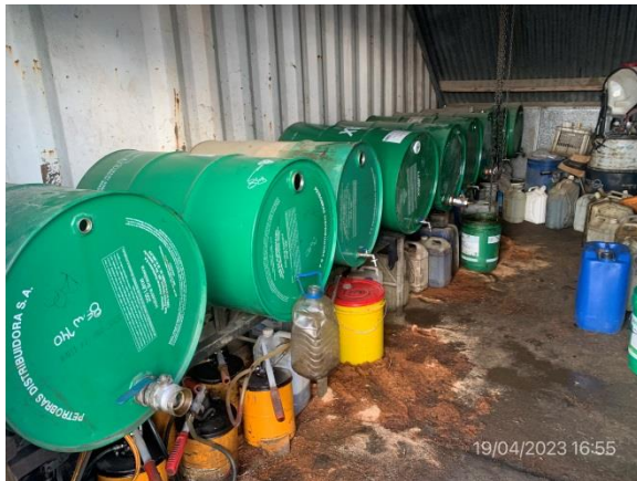
Ilustración 10 – P05. Obrador, sector techado y envallado para trasiego de lubricantes.
