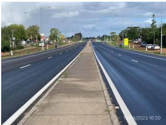
Ilustración 6 – Obras de recapado asfáltico en doble vía de Ruta 101.
