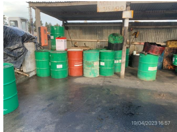
Ilustración 11 – P05. Obrador, acopio envallado de lubricantes usados.
