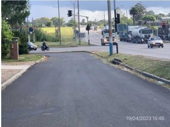
Ilustración 4 – Obras obligatorias terminadas en calles laterales de Ruta 102.
