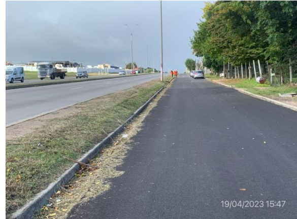
Ilustración 5 – Obras obligatorias terminadas en calles laterales de Ruta 102.
