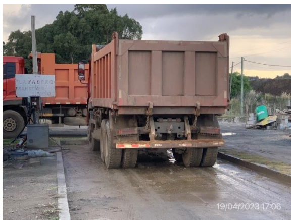
Ilustración 12 – P05. Obrador. Sector para lavado de camiones con pendientes hacia sistema de decantación.
