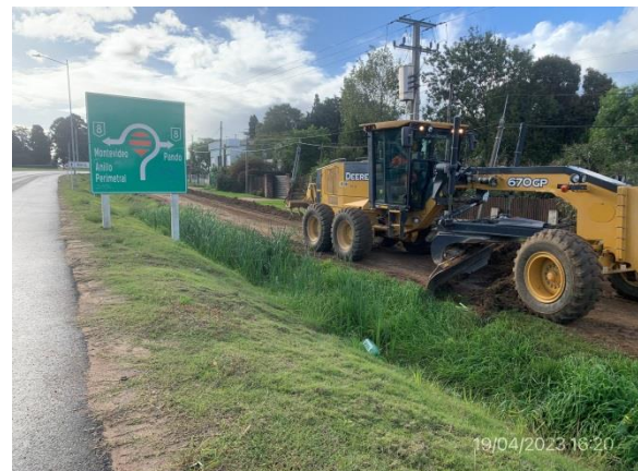
Ilustración 7 – Perfilado en ejecución de calles laterales de Ruta 101.
