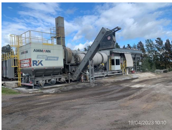
Ilustración 8 – P03, Planta asfáltica con actividad momentáneamente detenida.
