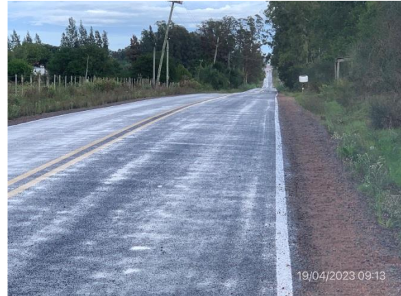
Ilustración 5 – Obras terminadas en Ramal de Ruta 36. Carpeta de rodadura en micropavimento en frío y obras de señalización terminadas.
