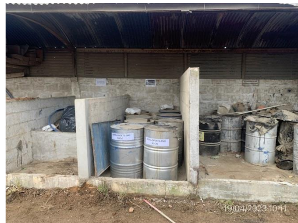
Ilustración 13 – P03, Obrador. Local techado con pavimento y envallado impermeables para acopio de tarrinas con residuos peligrosos.
