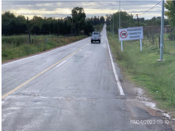
Ilustración 4 – P01, inicio de tramo de obras en Ramal de Ruta 36. Empalme en Ruta 36 progresiva 42K100.
