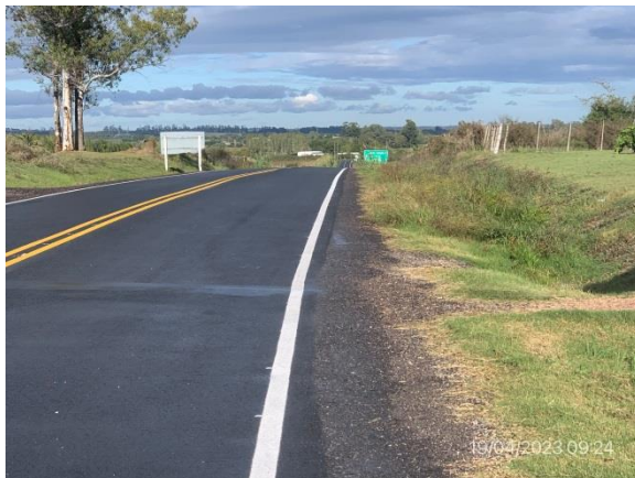
Ilustración 6 – Obras terminadas en Ramal de Ruta 36. Carpeta de rodadura en carpeta asfáltica y obras de señalización terminadas.
