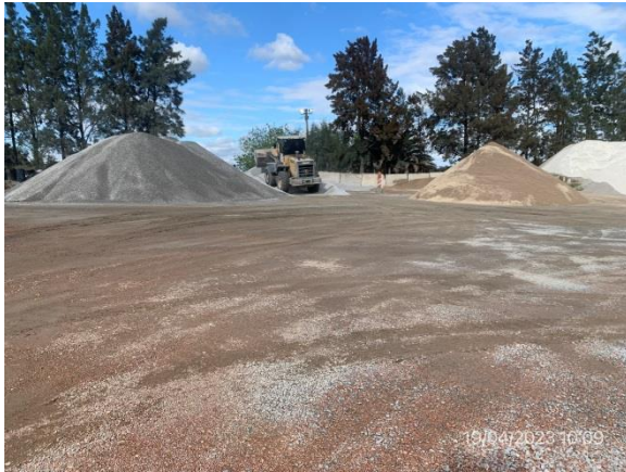
Ilustración 10 – P03 Obrador. Explanada de acopio de áridos
