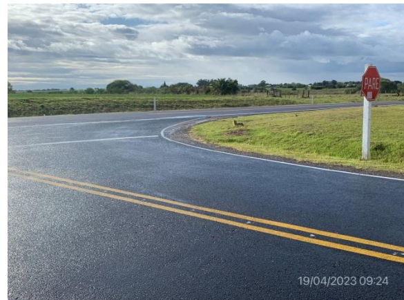
Ilustración 7 – P02, fin de tramo de obras en Ramal de Ruta 36. Empalme en Ruta 46 progresiva 52K400.
