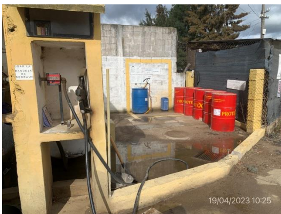
Ilustración 14 – P03, Obrador. Estación de abastecimiento de combustible con pavimento y envallado impermeable.
