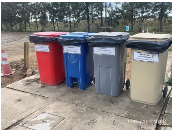
Ilustración 12 – P03, Obrador. Estación de acopio de residuos segregados por corriente de generación.
