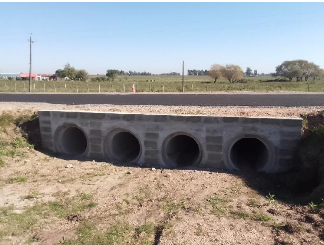
Reconstrucción de alcantarillas.
