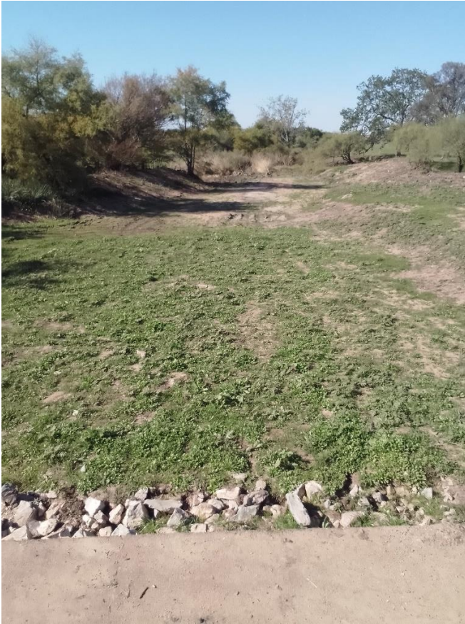
Relleno de socavación en la cañada Tabarez Chico.
