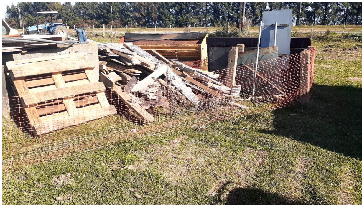
Residuos inertes delimitados mediante un recinto.
