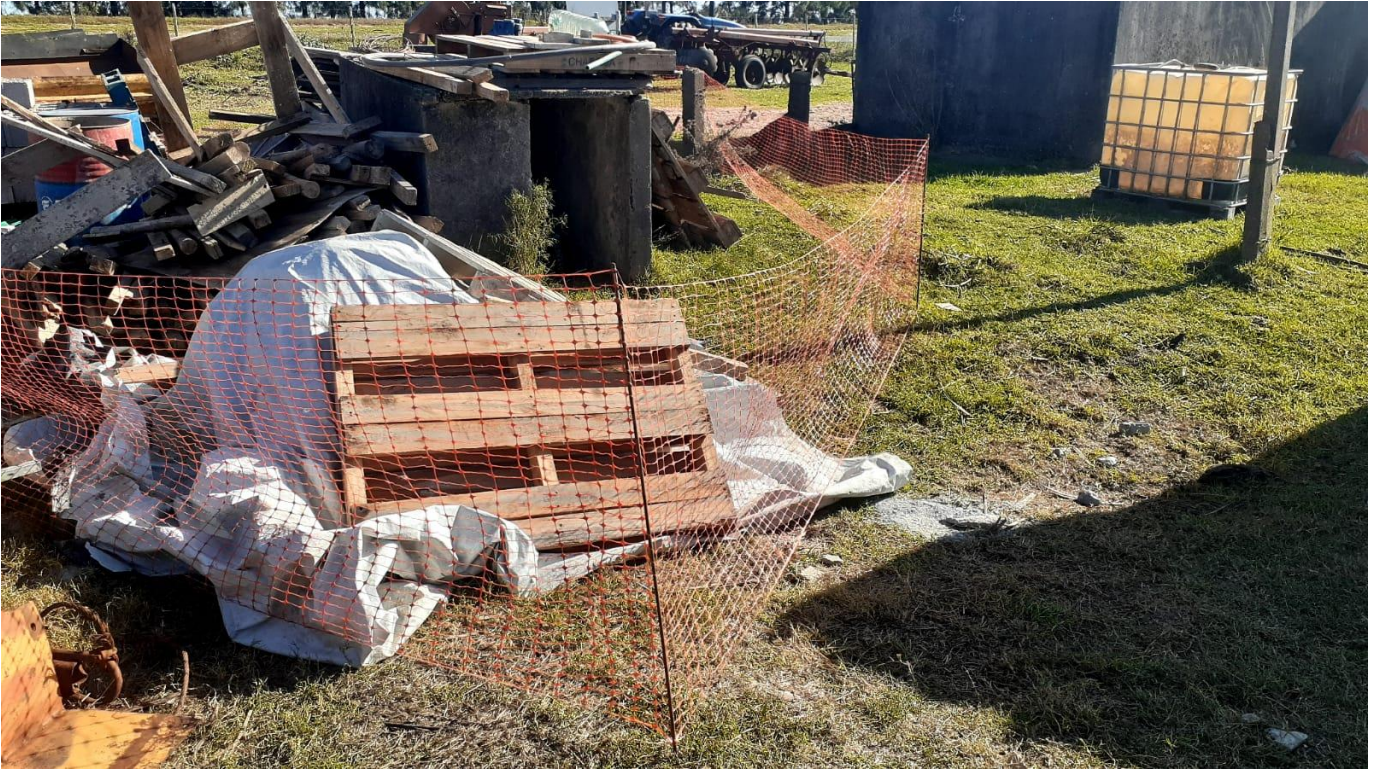
Residuos inertes delimitados mediante un recinto.
