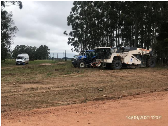
Ilustración 12 – Ruta 44. Estacionamiento de maquinaria en faja pública.
