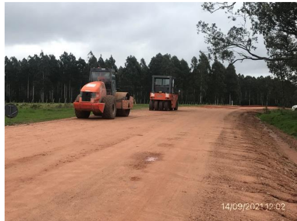
Ilustración 7 – P05, Frente de obras. Ruta 44, 17K100.
