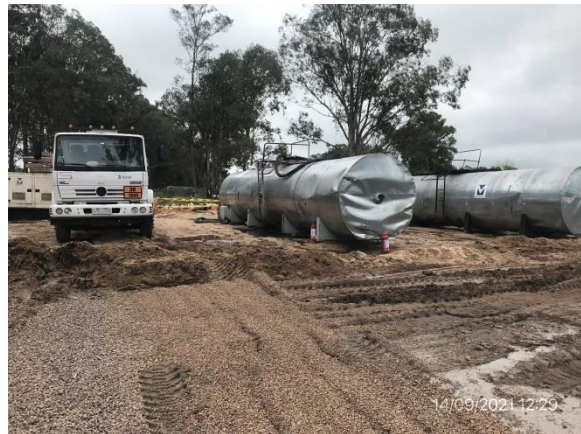
Ilustración 13 – P03, Obrador. Depósitos de emulsiones asfálticas con envallado perimetral impermeable.
