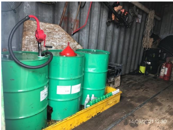
Ilustración 14 – P03, Obrador. Sector de acopio y trasiego de lubricantes en receptáculo techado e impermeable.
