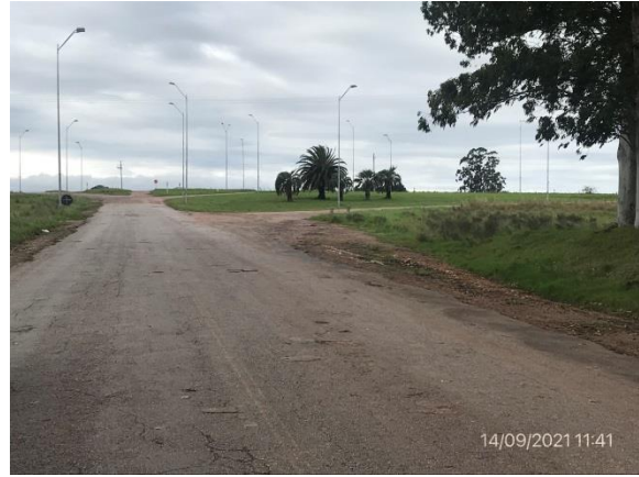
Ilustración 5 – P01, Inicio de tramo, Ruta 44, 6K500. Empalme con Ruta 26.
