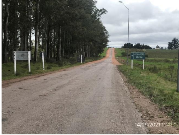
Ilustración 4 – P01, Inicio de tramo. Ruta 44, 6K500. Empalme con Ruta 26.
