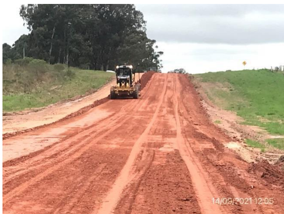
Ilustración 8 – P05, Frente de obras. Ruta 44, 17K100.
