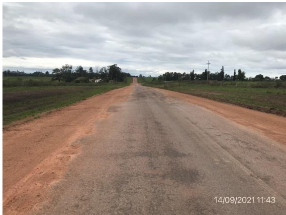
Ilustración 6 – Ruta 44, trabajos de ensanche de plataforma ejecutados.
