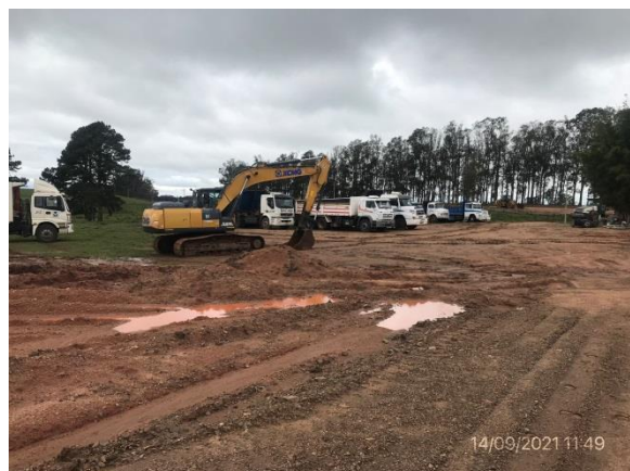
Ilustración 9 – P04, Cantera de arenisca. Ruta 44, 14K000 a (+). Estacionamiento de maquinaria.
