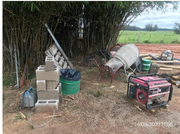
Ilustración 11 – P04, Cantera de arenisca. Infraestructura precaria para gestión segregada de residuos.
