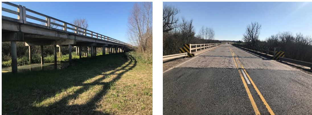
Figura 4-7 Imágenes puente arroyo Pantanoso
