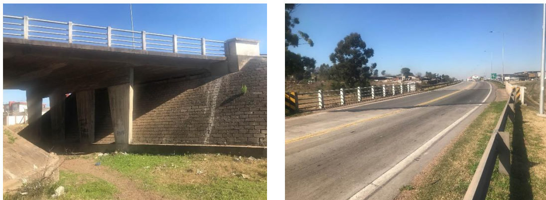
Figura 4-4 Imágenes del puente Ferroviario 2
