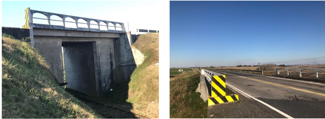
Figura 4-3 Imágenes del puente Ferroviario 1
