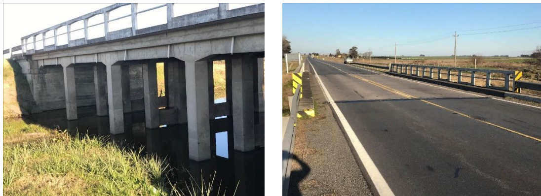
Figura 4-1 Imágenes del puente Aº La Lancha
