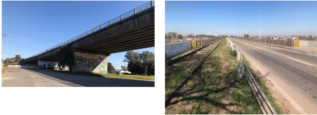
Figura 4-10 Imágenes del puente ferroviario sobre el río Negro
