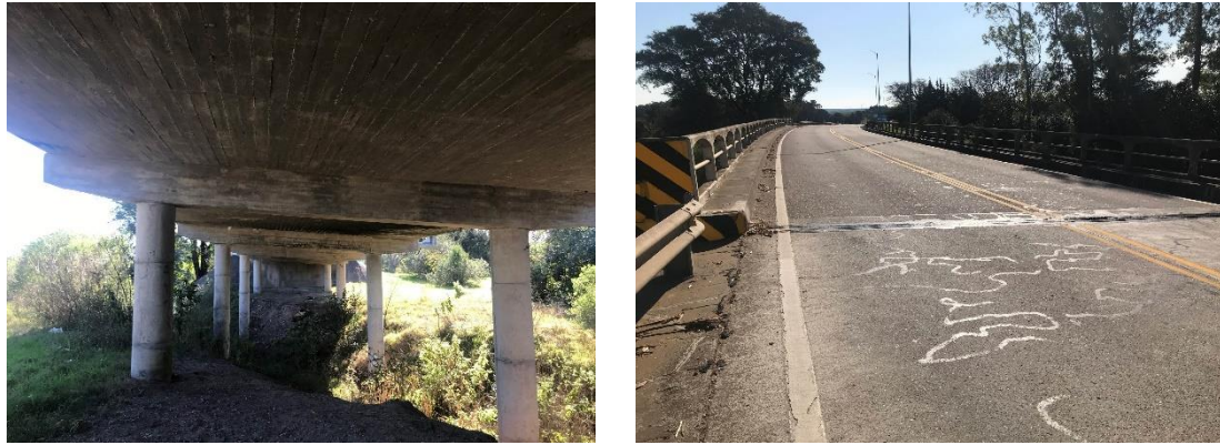
Figura 4-8 Imágenes de puente 8
