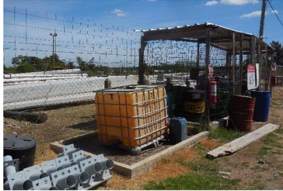
Figura 3-4 Recinto de almacenamiento de combustible en obrador principal
