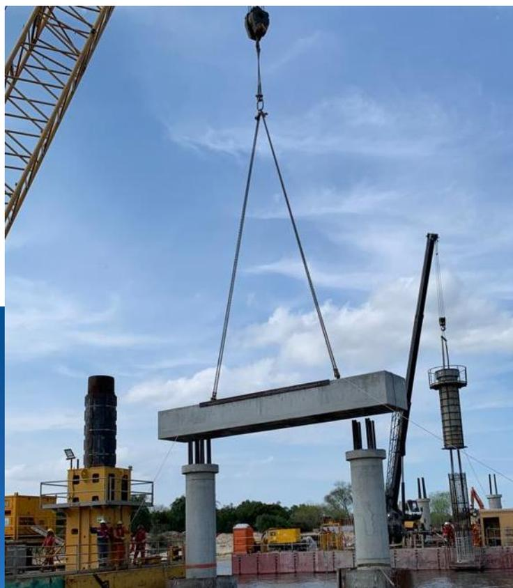
**Figura 4:** Montaje dinteles
