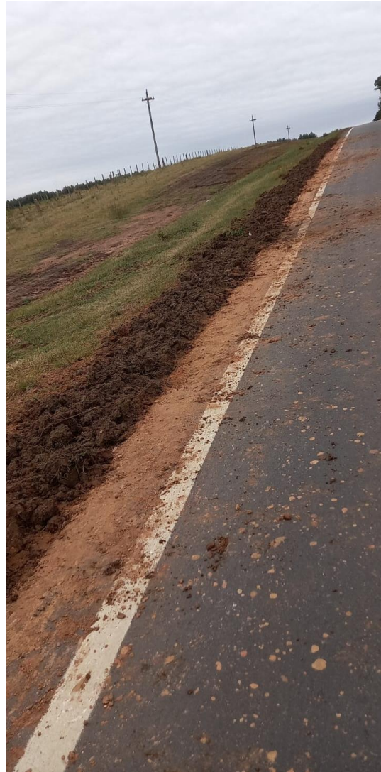
Imágenes 3 y 4 – Zona reconstruida y con tendido de tierra negra para favorecer empastado.
