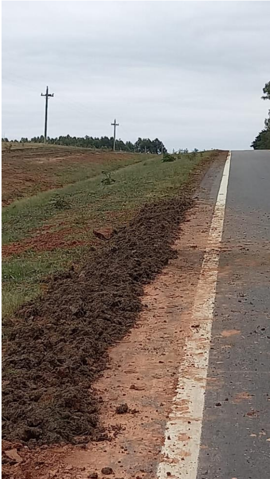
Imágenes 3 y 4 – Zona reconstruida y con tendido de tierra negra para favorecer empastado.
