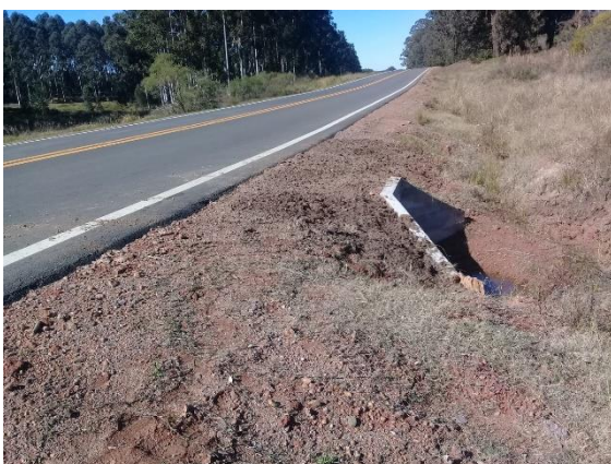
Imágenes 5 y 6 – Zona de alcantarilla reconstruida y con tendido de tierra negra para favorecer empastado.
