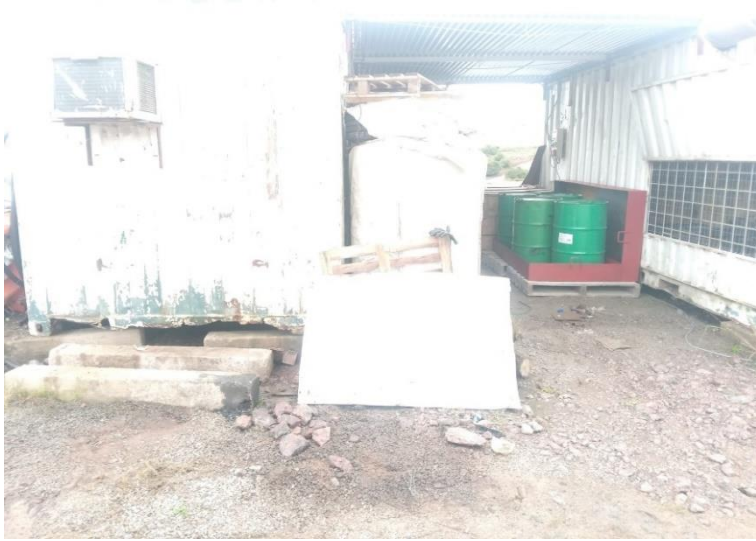
Imagen 1 – Tarrinas de aceite bajo techo y con contención para derrames.
