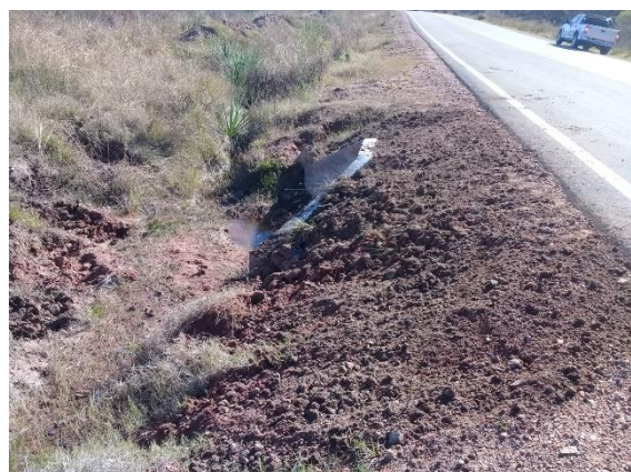
Imágenes 5 y 6 – Zona de alcantarilla reconstruida y con tendido de tierra negra para favorecer empastado.
