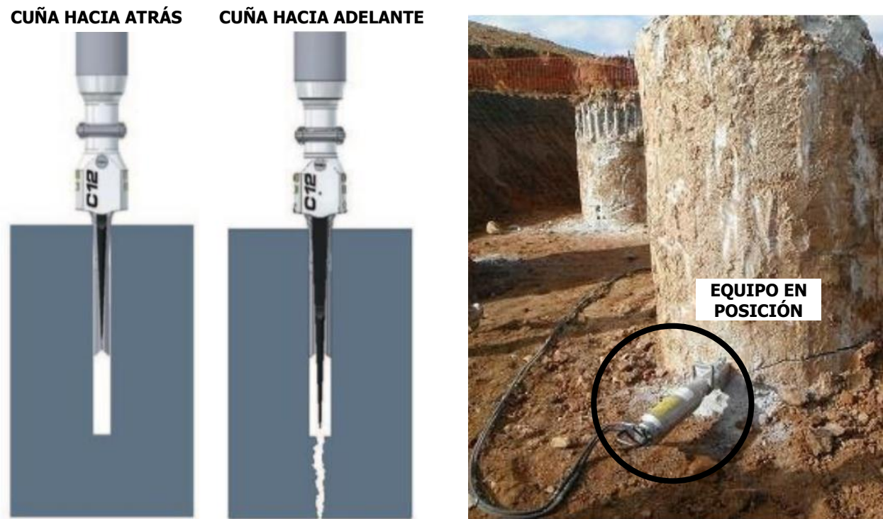
Figura 4: Funcionamiento y posición del equipo
