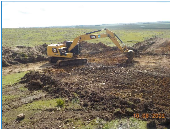
Destape de cantera. Inicio de recargo y circulación de tráfico pesado en zona de obras.
