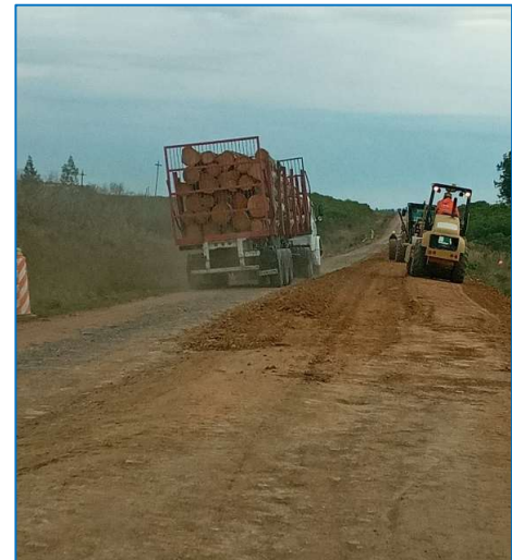
Destape de cantera. Inicio de recargo y circulación de tráfico pesado en zona de obras.
