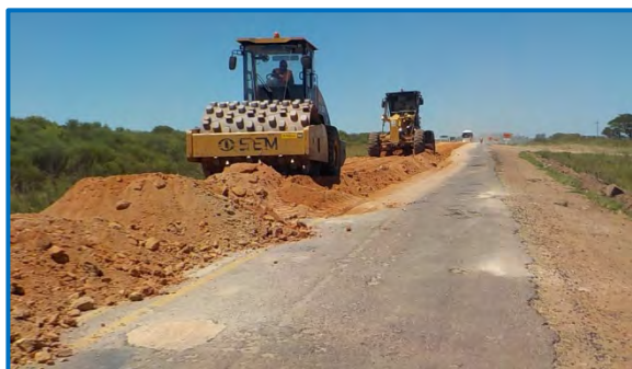
Recargo y compactación de material granular.
