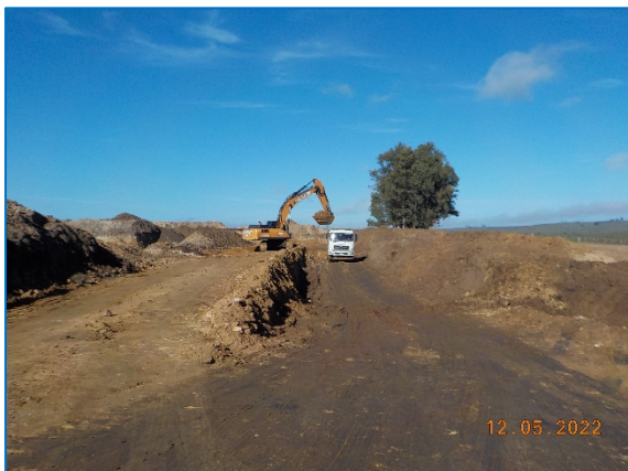
Arranque carga, transporte y extendido de material granular para refuerzo de pavimento.
