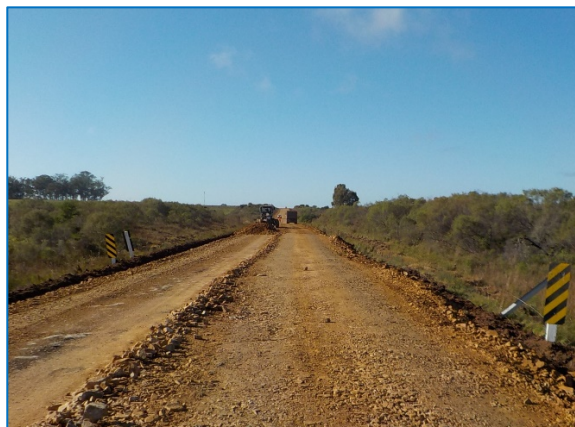
Arranque carga, transporte y extendido de material granular para refuerzo de pavimento.
