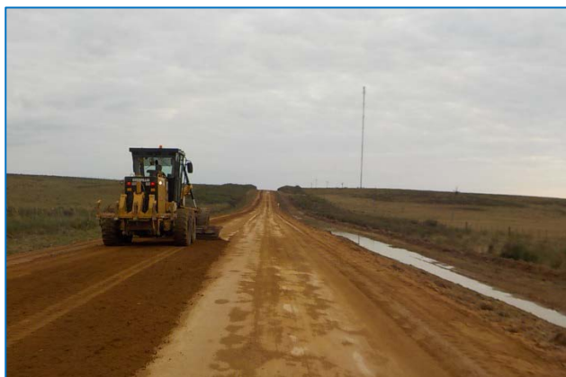
Mantenimiento de calzada recargada y de calzada preexistente de Ruta 27, durante el período en que no se realizaron tareas con productos asfálticos, ni preparación o reciclado de bases debido a la veda e indicaciones del Comitente.
