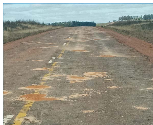
Mantenimiento de calzada recargada y de calzada preexistente de Ruta 27, durante el período en que no se realizaron tareas con productos asfálticos, ni preparación o reciclado de bases debido a la veda e indicaciones del Comitente.
