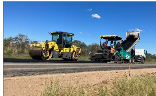
Primeras jornadas de elaboración y tendido de mezcla asfáltica en caliente.
