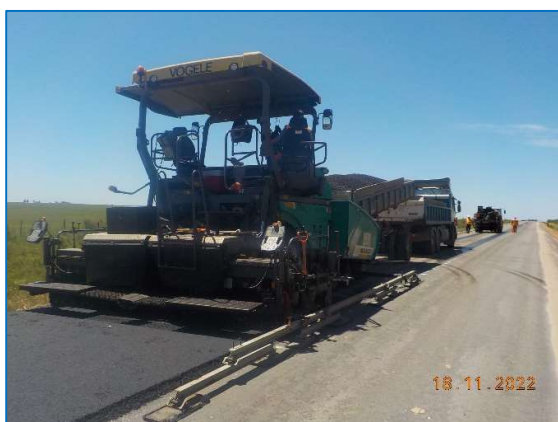
Pavimentación de calzada y evaluación de regularidad superficial.
