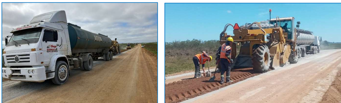
Aplicación de agua para el mezclado del material reciclado con cemento.
