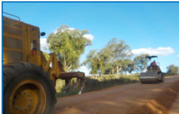
Extendido de material granular.
