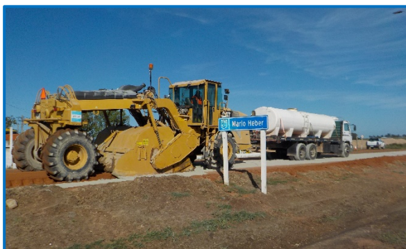
Mezclado en sitio de la base del pavimento.
