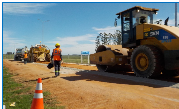
Compactación y control del material reciclado
