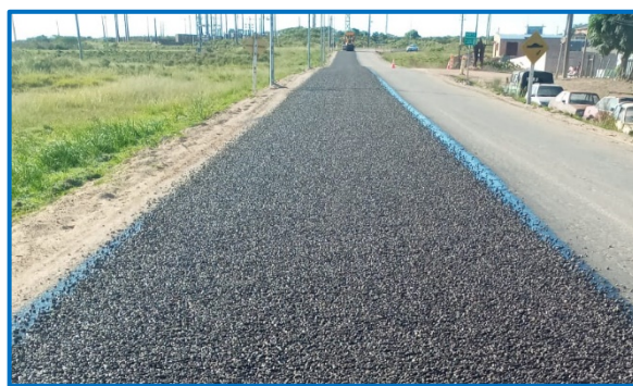
Base imprimada y con TBS.
