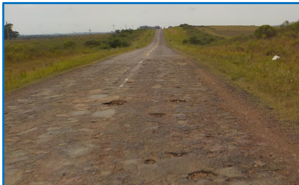
Situación típica de la calzada previo a la rehabilitación.
