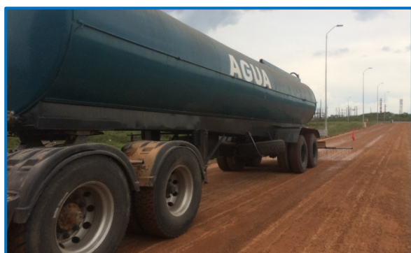
Riego aplacador de polvo.
