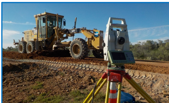
Refine de base cementada.
