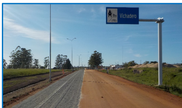
Aplicación de cemento en capa a reciclar.
